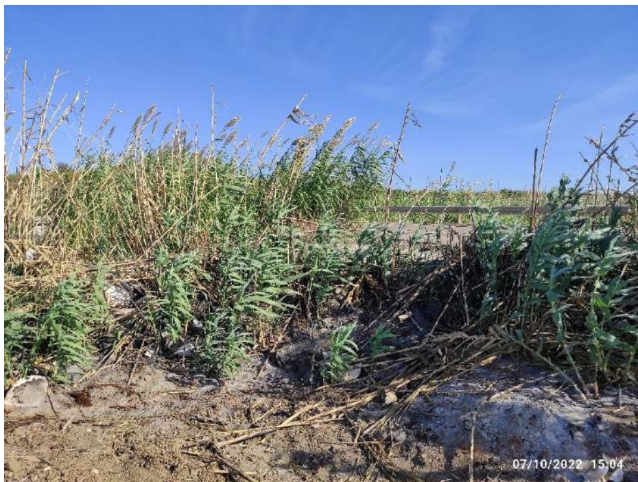
Figura 37: Interferenza n.27 con reticolo e presenza ponte
