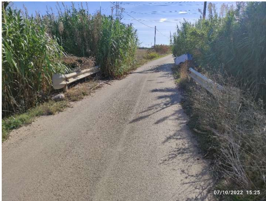
Figura 42: Interferenza n.34 con reticolo e presenza ponte
