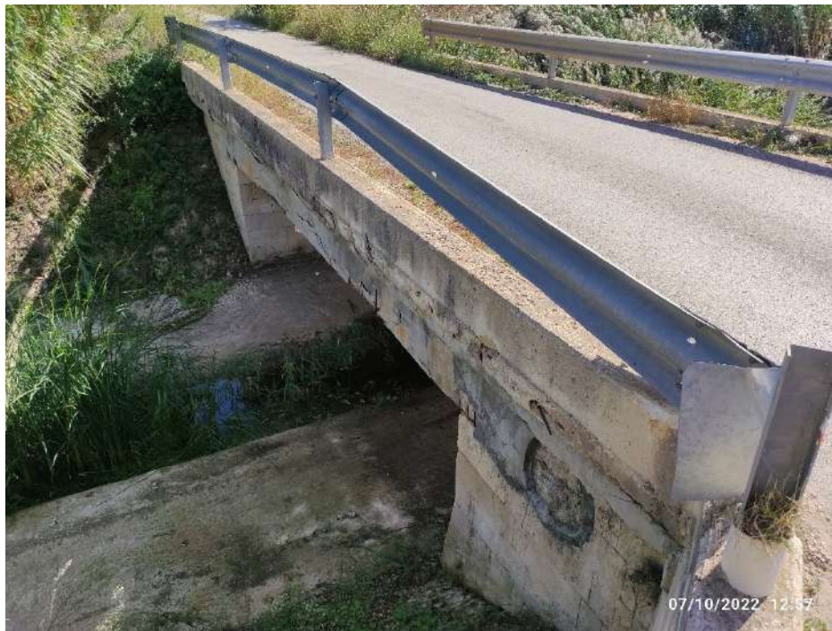
Figura 26: Interferenza n.10 con reticolo e presenza ponte
