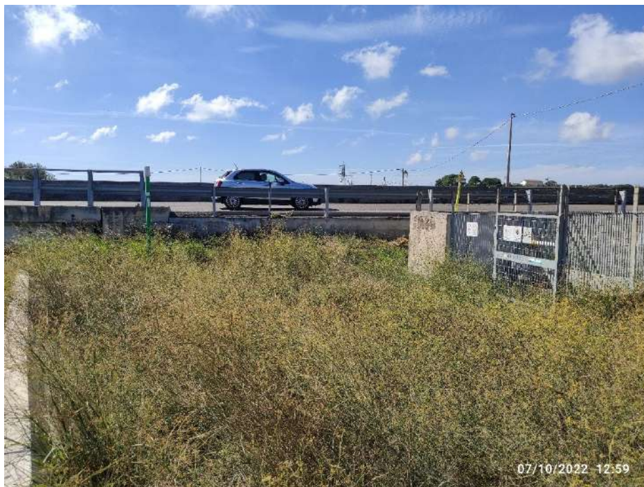
Figura 27: Interferenza n.11 con metanodotto e n.12 con strada statale
