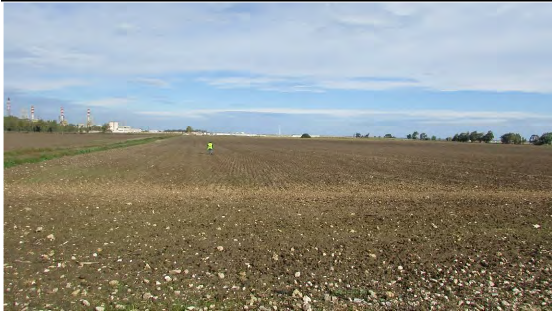
Figura 14.1 Brindisi (BR), UR 1 campo fotovoltaico, panoramica dell'area destinata all'impianto fotovoltaico, dal limite S in direzione N
