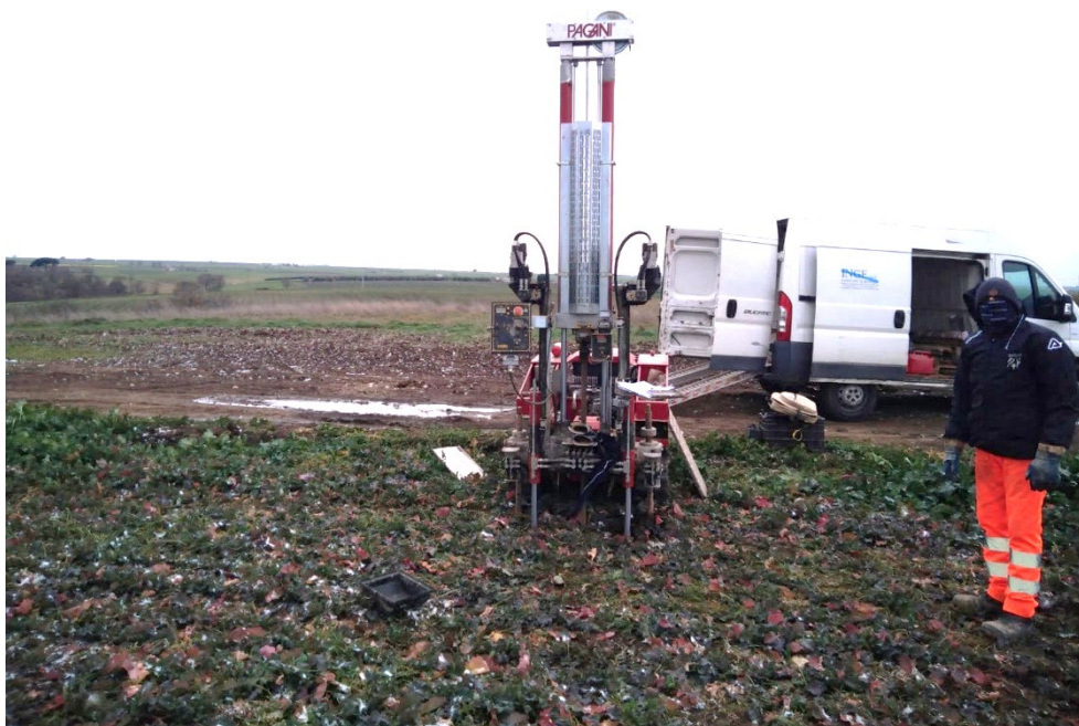
Prova Penetrometrica Dinamica Pesante DPSH 01
