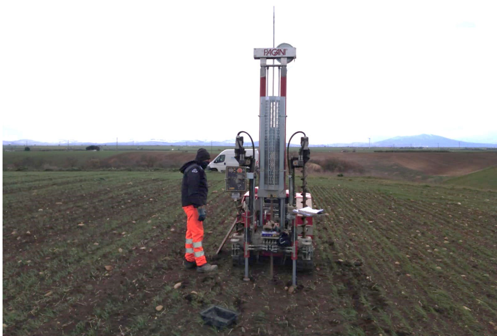
Prova Penetrometrica Dinamica Pesante DPSH 02
