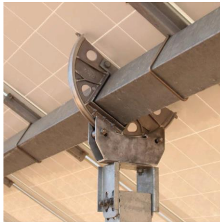
figura 8: schema nodo trave continua / colonna
