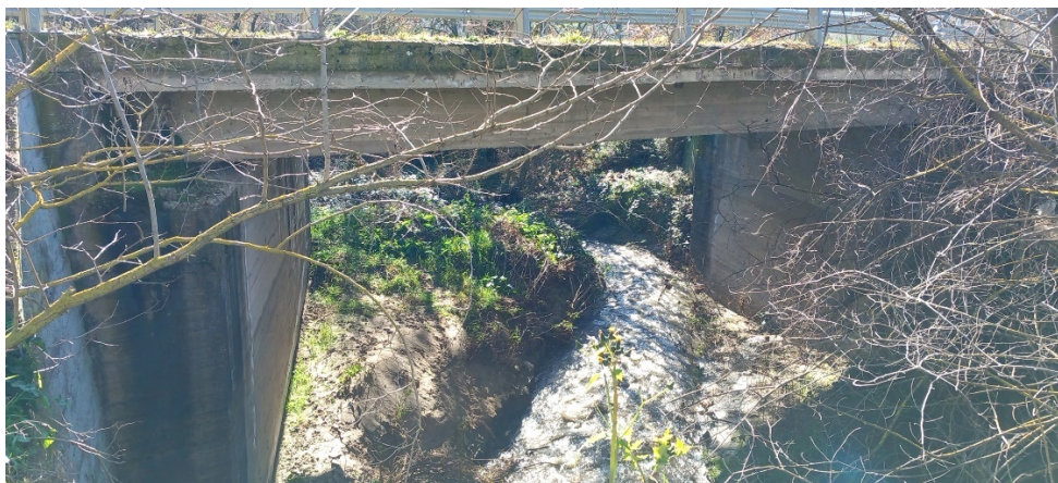
Figura 22 - Scatto effettuato presso la I06 che mostra la tipologia di attraversamento stradale presente
