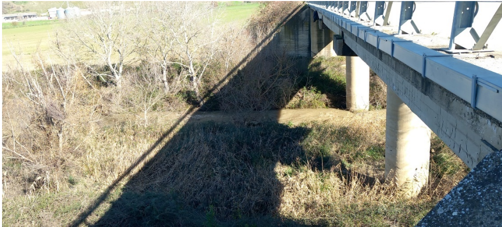
Figura 26 - Scatto effettuato presso la I08 che mostra la tipologia di attraversamento stradale presente e il cavidotto esistente
