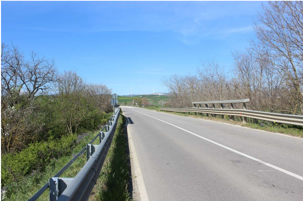
Figura 23 Attraversamento del cavidotto su ponte sull'affluente del fiume Bradano
