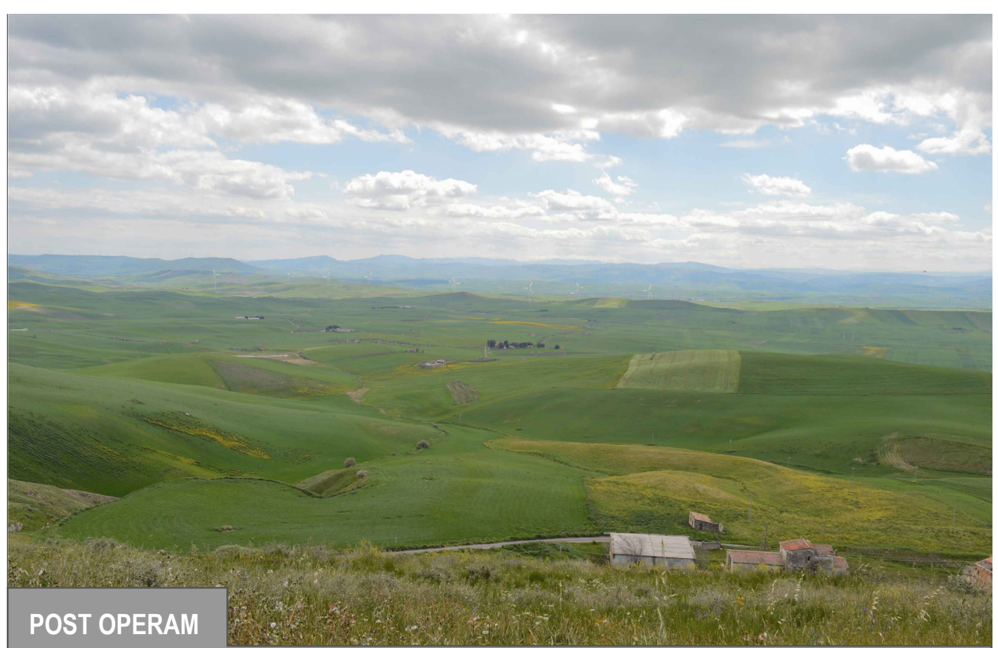
F.1 Il punto di osservazione scelto può considerarsi di massima visibilità per l'impianto. Il parco è visibile nella sua interezza al centro della foto, inserito in un campo visivo di sfondo. Da questa distanza la percezione degli aerogeneratori risulta attenuata dalle condizioni atmosferiche e la presenza degli stessi non prevale sul contesto generale, costituito da un paesaggio aperto, configurato dalla morfologia collinare. Il paesaggio nel complesso mostra una buona capacità di assorbimento visivo del progetto; la posizione dominante dell'osservatore da questo punto amplifica lo sguardo, il quadro visivo appare aperto ma la forma degli oggetti si percepisce non incombente.
