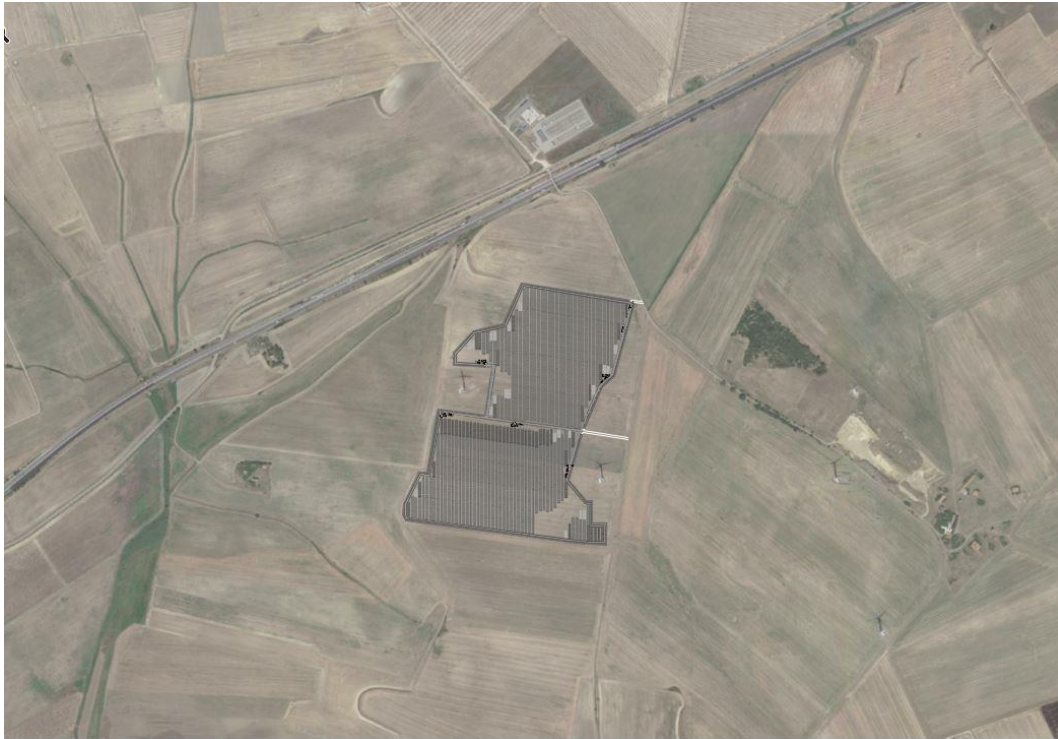
Figura 1-stralcio fotogrammetrico con il campo fotovoltaico
