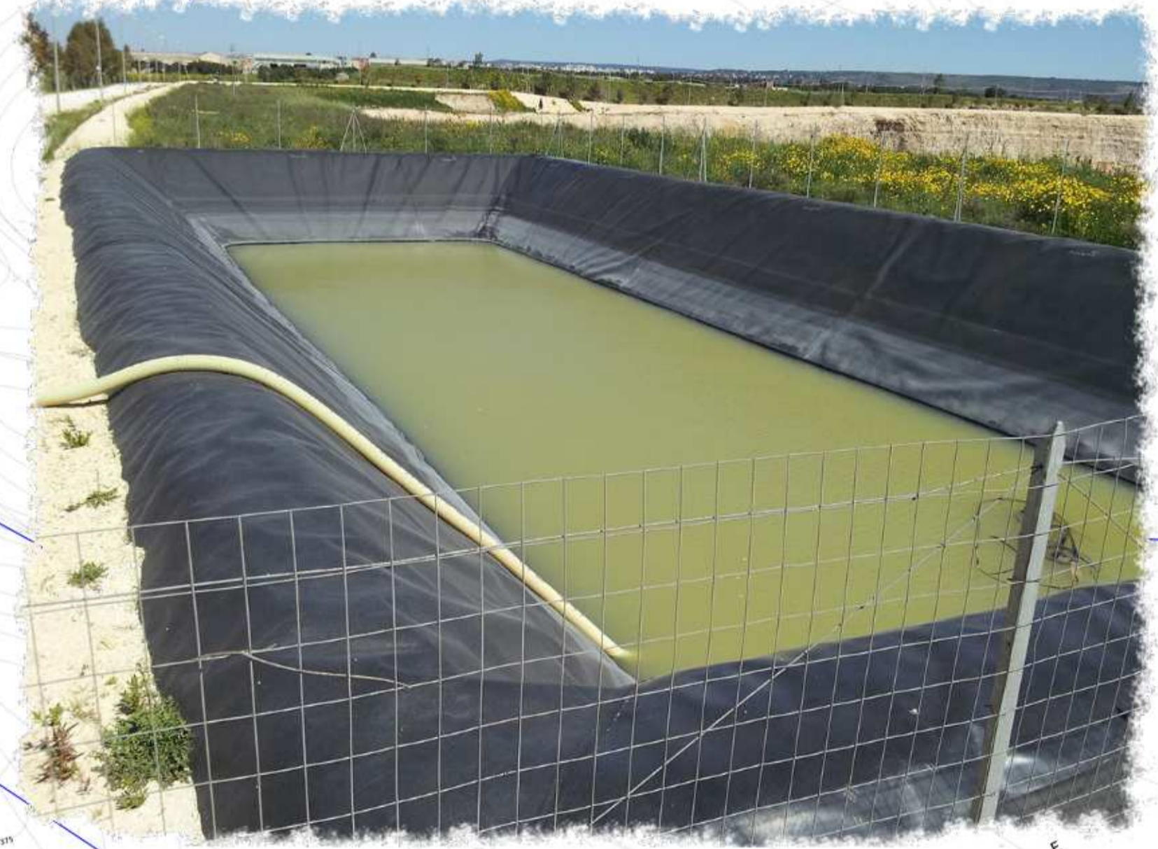
Esempio di vasca raccolta acque piovane
