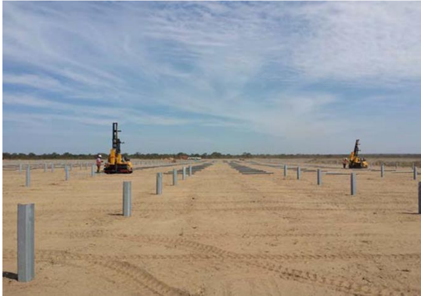
Figura 12 – Posa in opera profili di palificazione
