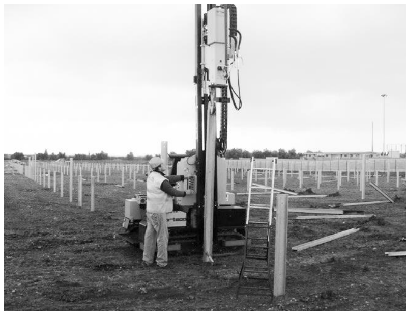
Figura 13 – Infissione con macchina battipalo
