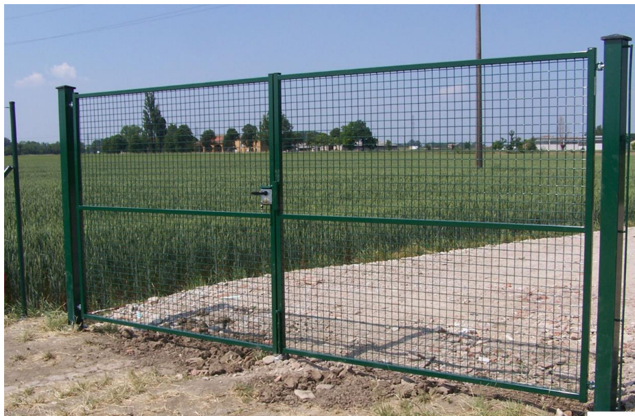
Figura 03- Esempio tipologico cancello della recinzione perimetrale
