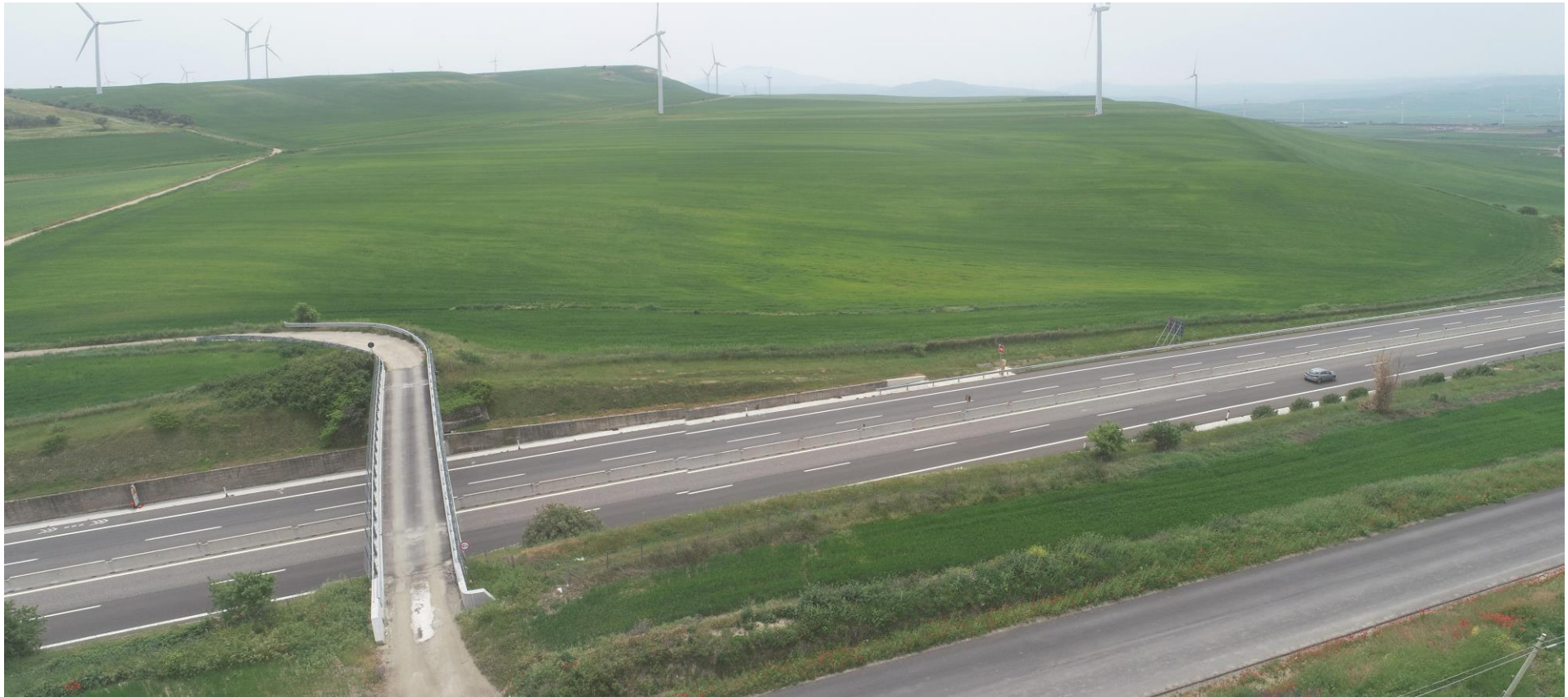
FOTO B - VISTA AEREA
