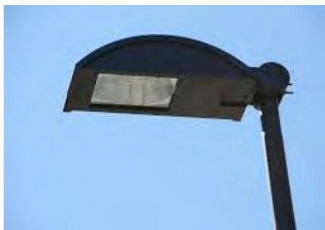
Figura 4.47: Esempio di apparecchio completamente schermato (full-cut-off).
