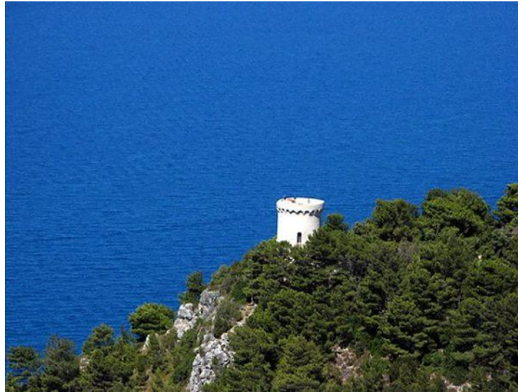
Figura 98. Torre di Capo d'Uomo (Fonte: https://www.maredellatoscana.com/vacanze/torre-di-capo-duomo-2/ )
