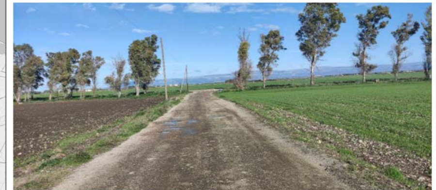
Viabilità in conglomerato bituminoso esistente
