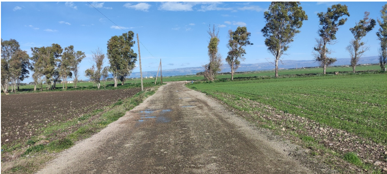
Viabilità in conglomerato bituminoso esistente
