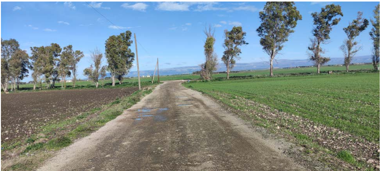
Viabilità in conglomerato bituminoso esistente
