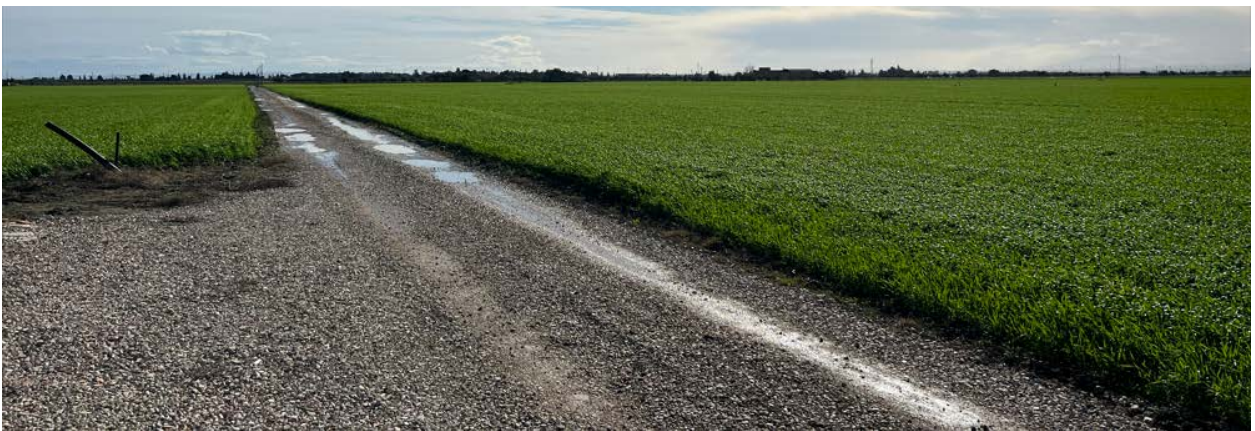
Viabilità esistente con pavimentazione naturale in discreto stato
