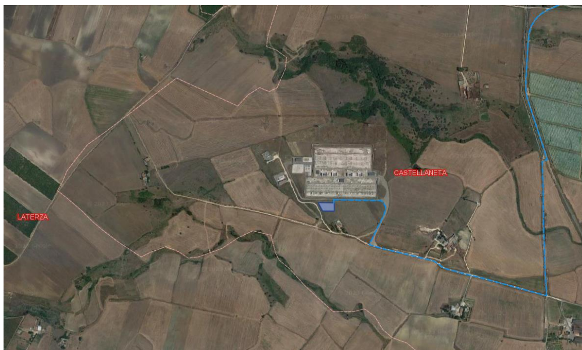
Figura 4-1: Ortofoto area di futura Stazione elettrica utente adiacente alla Stazione Terna "Castellaneta"
