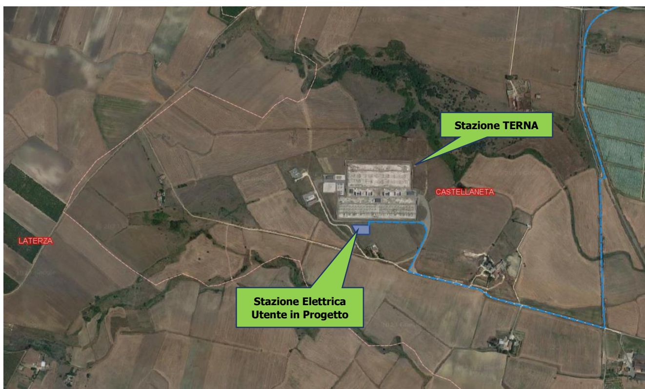
Figura 5-8: Ortofoto area di futura Stazione elettrica utente adiacente alla Stazione Terna "Castellaneta"
