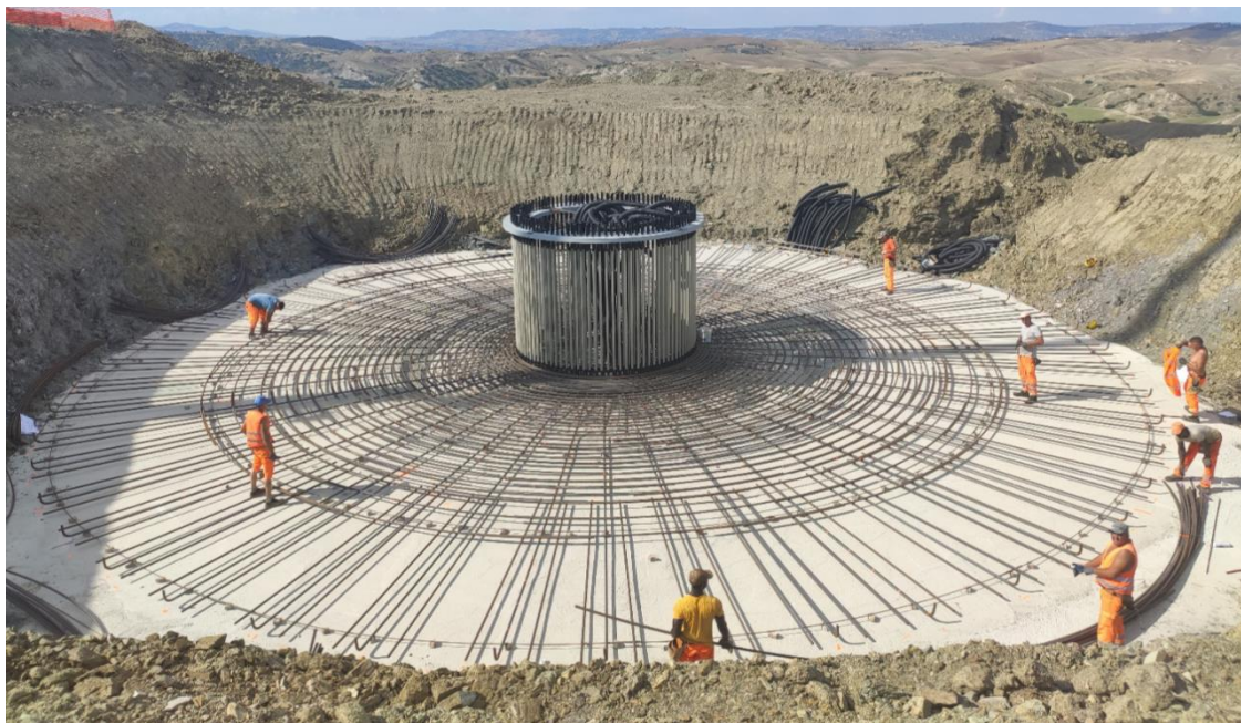
Figura 5-3: immagine tipo posa anchor cages
