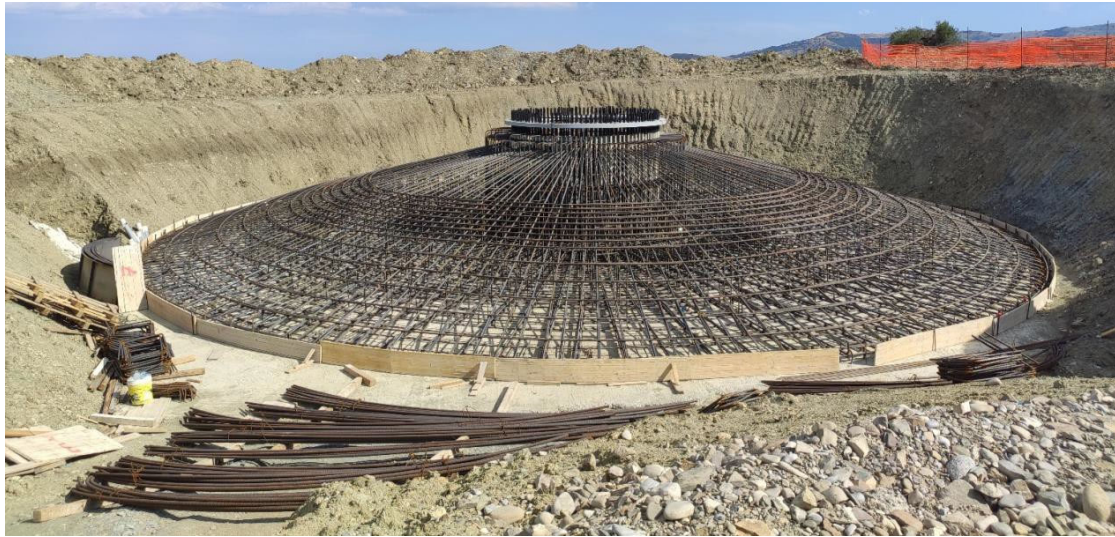
Figura 9: armatura plinto tipo
