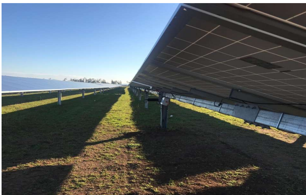
Figura 1 - Installazione del SunHunter - 12 MW Viterbo
