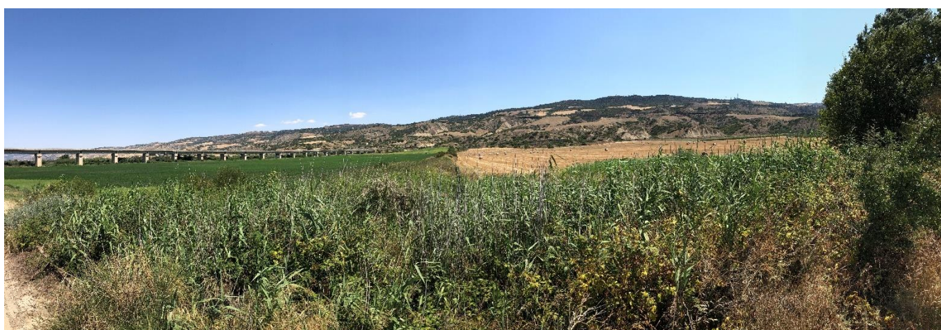
Figura 38: Vista dello stato dei luoghi della parte sud - occidentale dell'area di interesse (aprile 2022) – Foto 12
