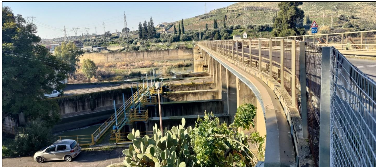
Figura 23: Infrastruttura idraulica presente lungo il tracciato del cavidotto. Foto realizzata durante il sopralluogo dei tecnici WSP.
