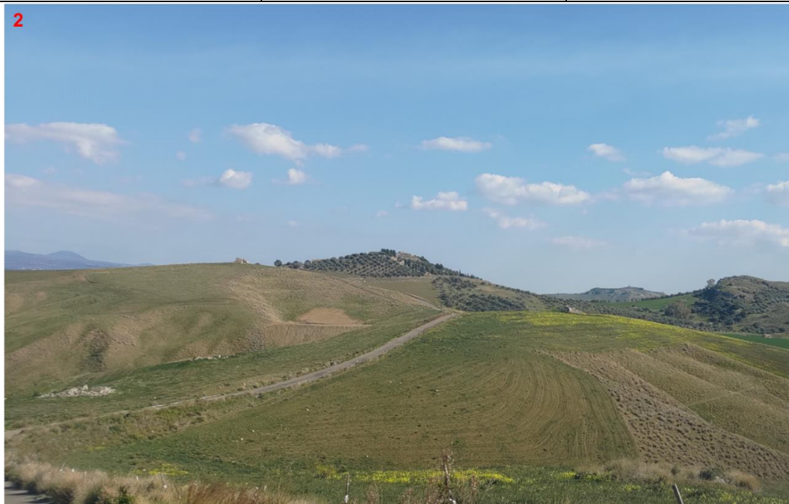
Figura 4 – Foto scattata in sito lungo la strada di accesso al Lotto 1 e 2. 1_Direzione Est verso i Lotti 1 e 2; 2_Direzione Est verso il Lotto 2
