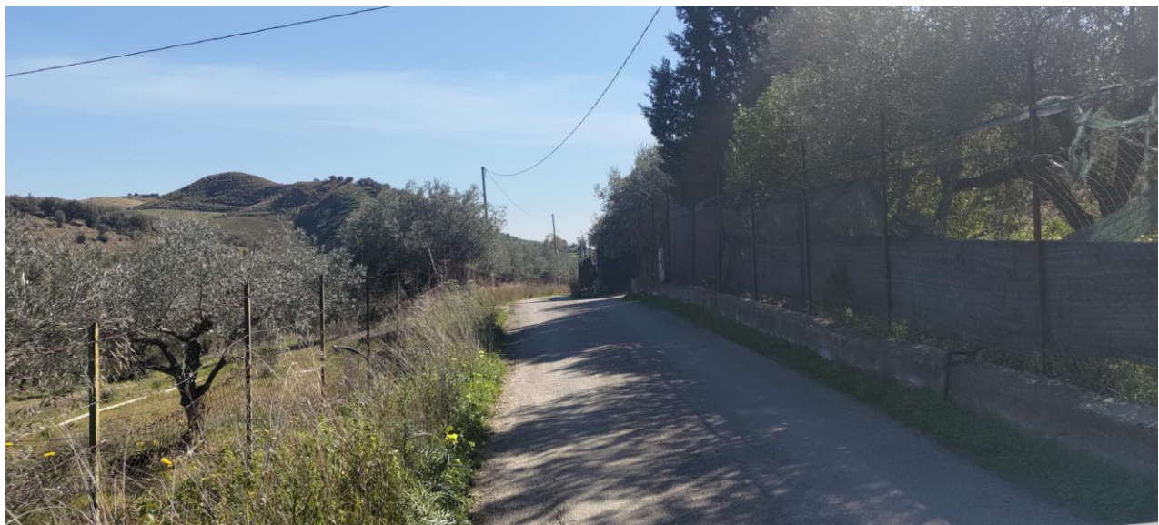
Figura 66 – PdV09 verso il lotto 5 – Direzione Ovest
