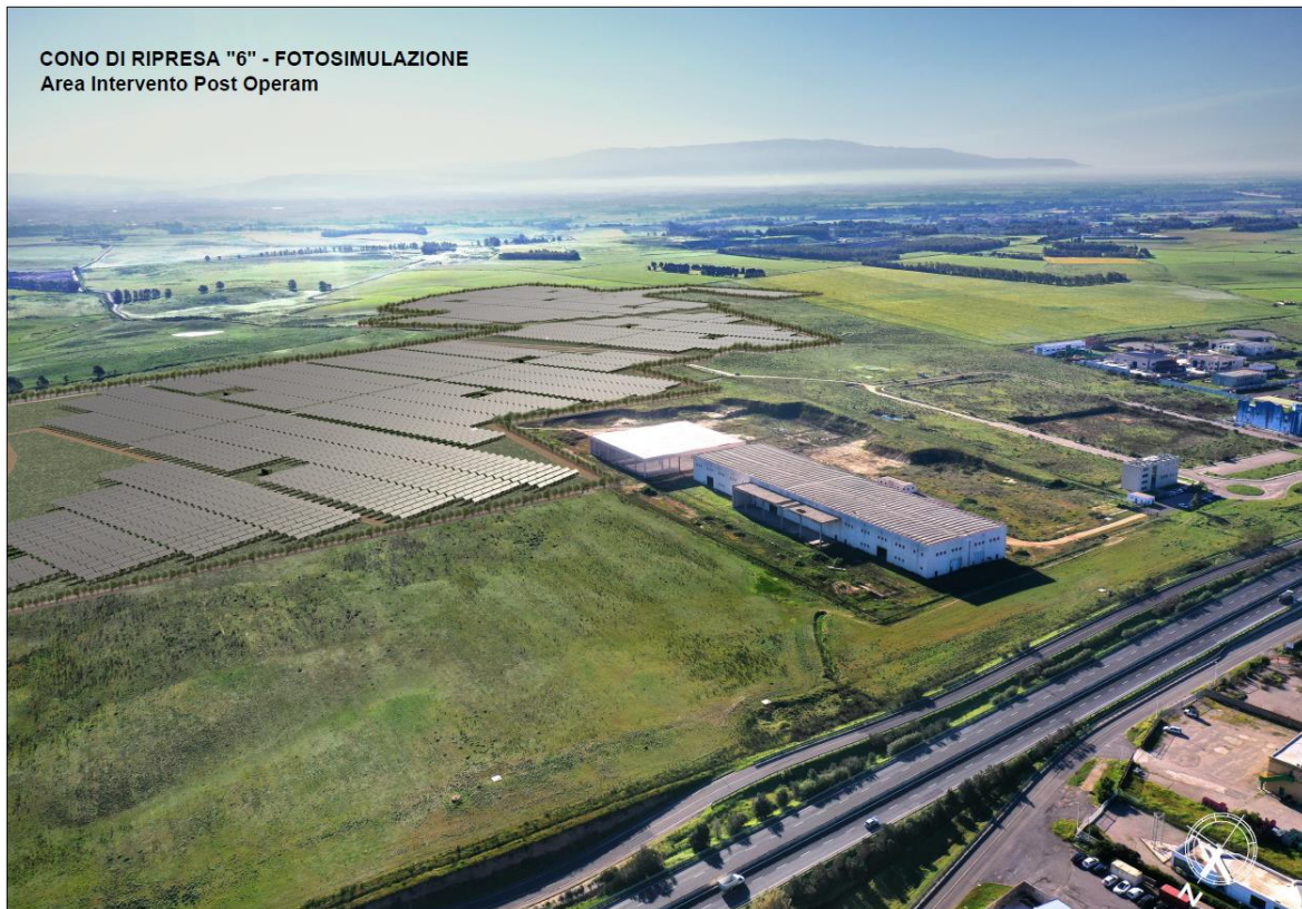
Figura 32: Cono di ripresa 6 – Area Intervento Post Operam
