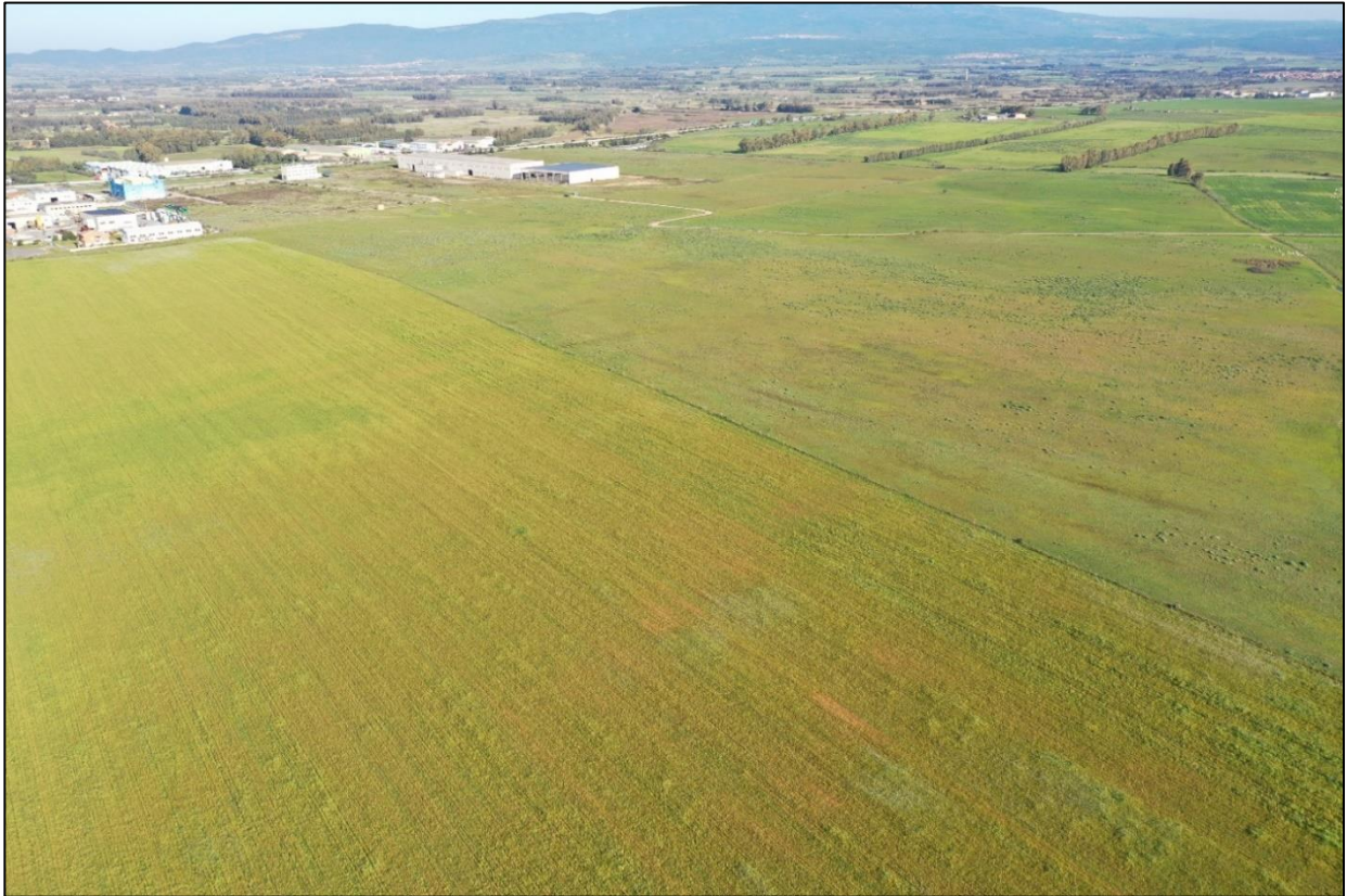
Figura 7: Foto Aerea da Sud-Est dello stato attuale dell'area
