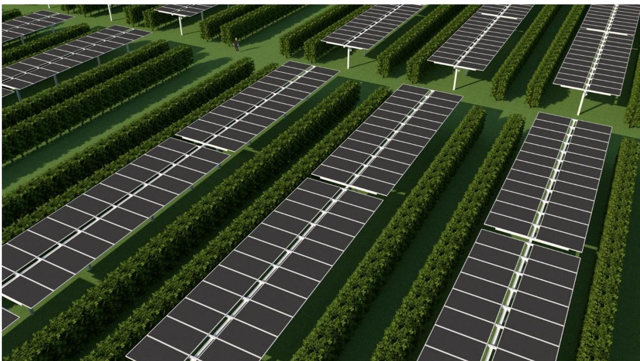
*Figura 120 - Particolare del modello, siepi ulivicole e tracker in posizione orizzontale*
