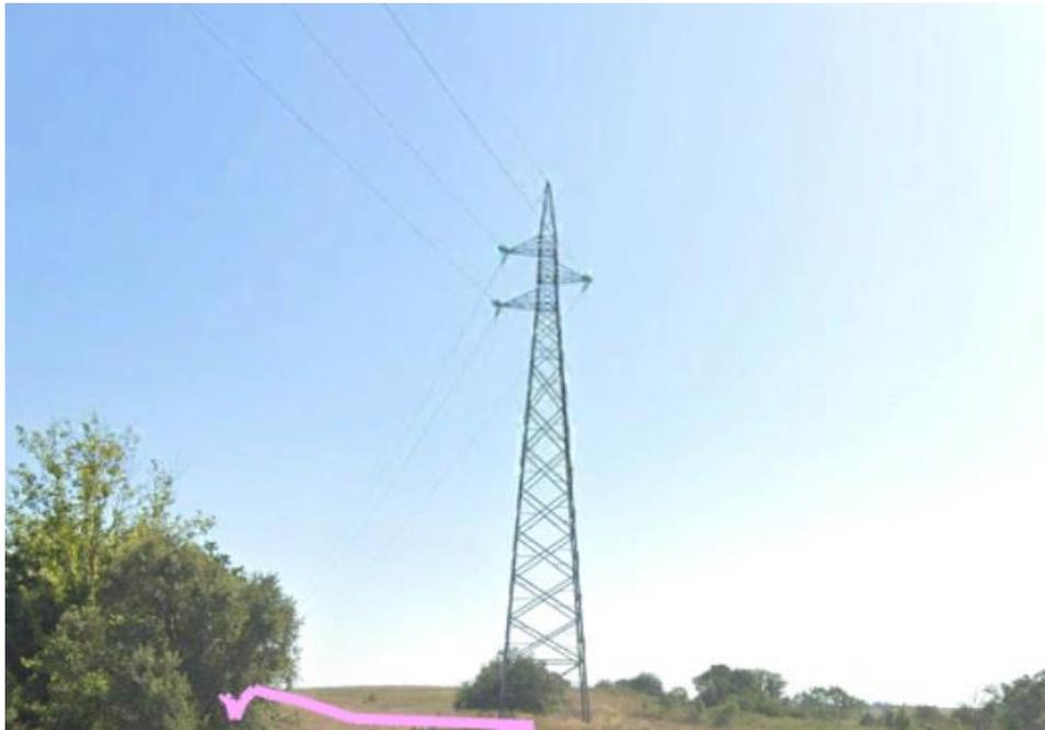
*Figura 52 - Traliccio tronco piramidale linea AT da 150 kV Canino-Montalto*
