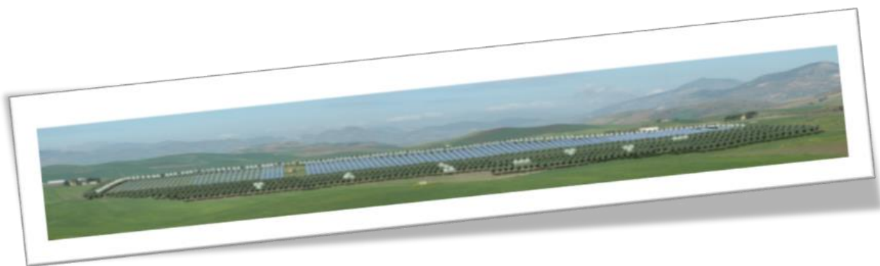
Figura 39 - Impianto fotovoltaico da 5 MW, "Heliospower", Monreale (PA) 2010
