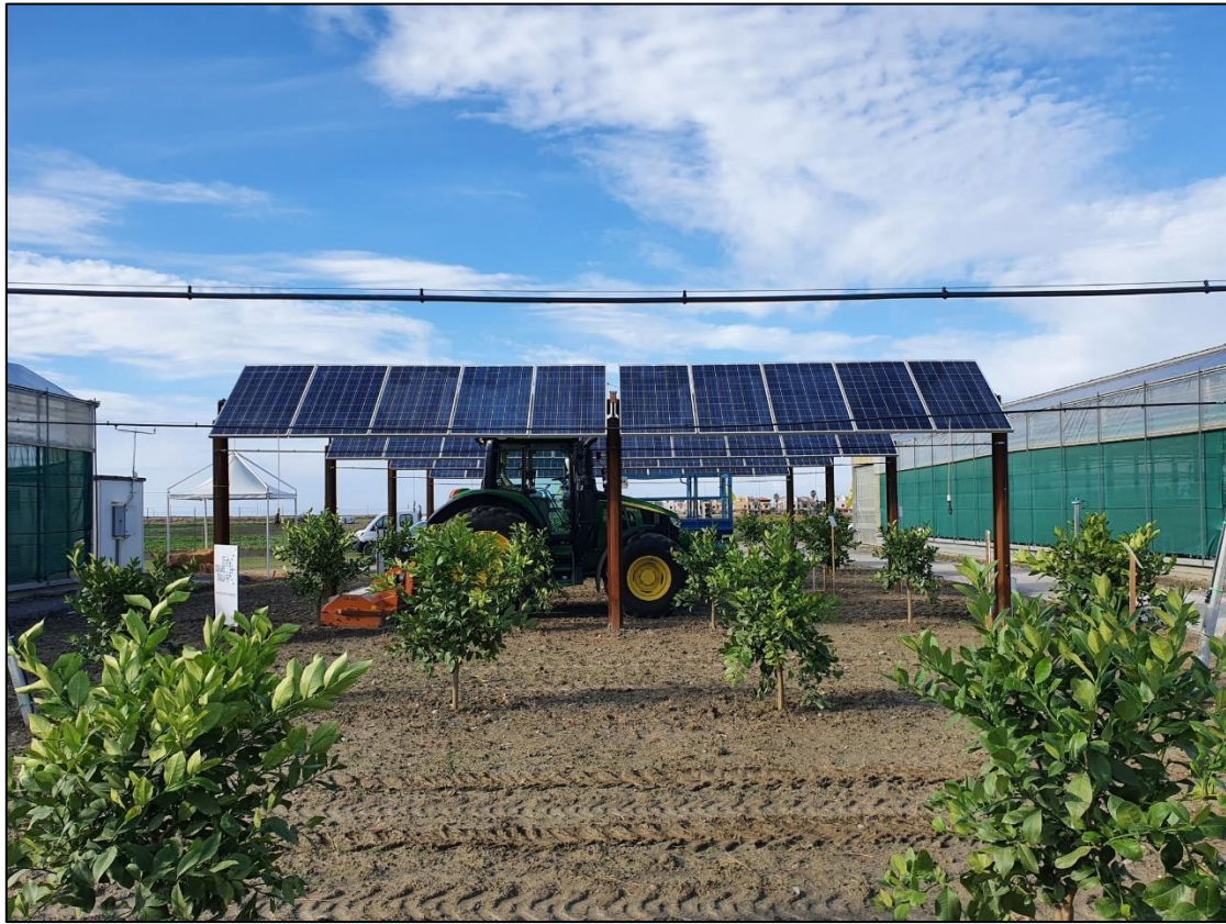
Foto 5: Foto di un impianto dimostrativo realizzato nel complesso agrivoltaico di Scalea (CS) gestito dal Consorzio Le Greenhouse.
