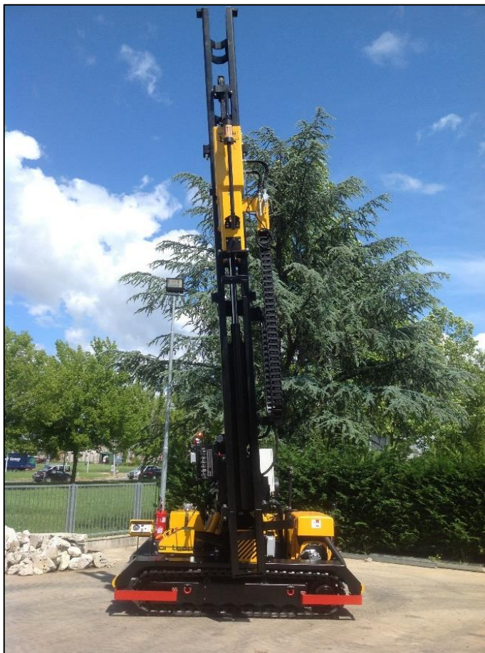
Figura 25: Macchina battipalo per l'infissione dei pali per i tracker.
