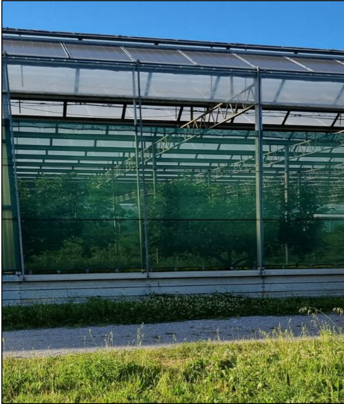
Figura 29: Foto delle serre agrivoltaiche dell'impianto di Scalea (CS), all'interno delle quali si coltivano agrumi (cedri e limoni). Si evidenzia la tipologia di rete frangivento che verrà utilizzata per i tracker dell'impianto agrivoltaico
