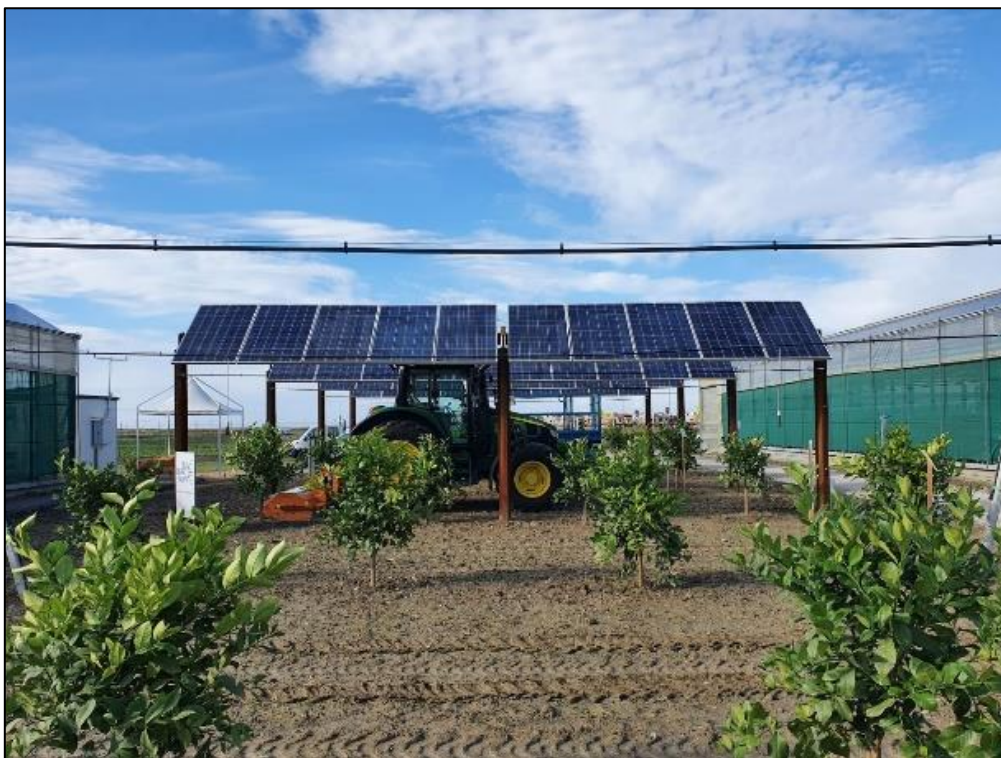
Figura 50: Foto di un impianto dimostrativo realizzato nel complesso agrivoltaico di Scalea (CS) gestito dal Consorzio Le Greenhouse.
