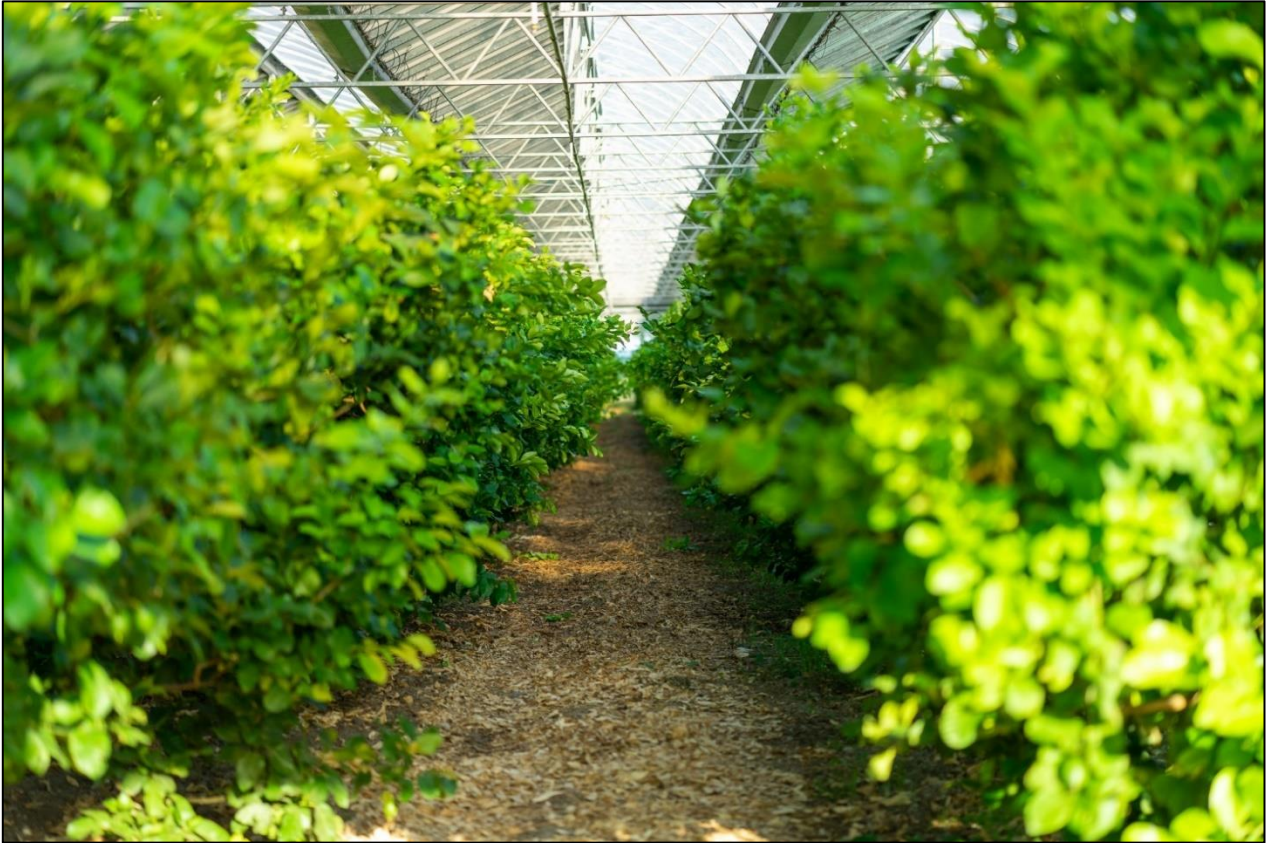
Foto 1: Serra fotovoltaica con coltivazione di limoni
