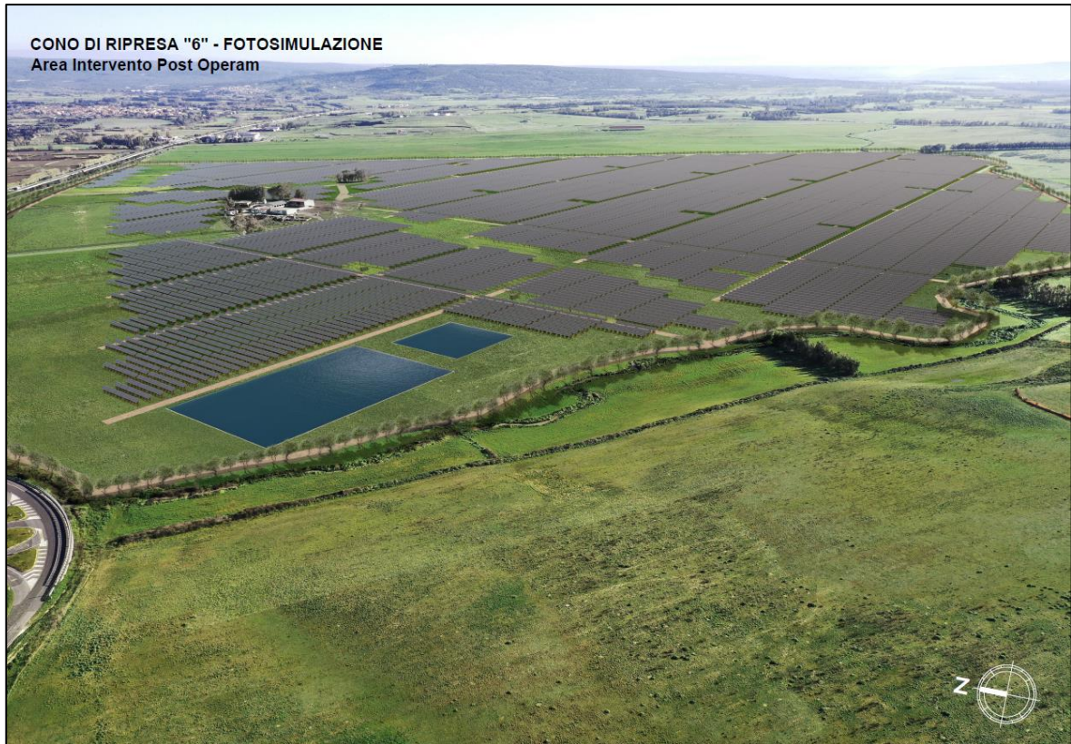
Figura 18: Cono di ripresa 6 – Area Intervento Post Operam
