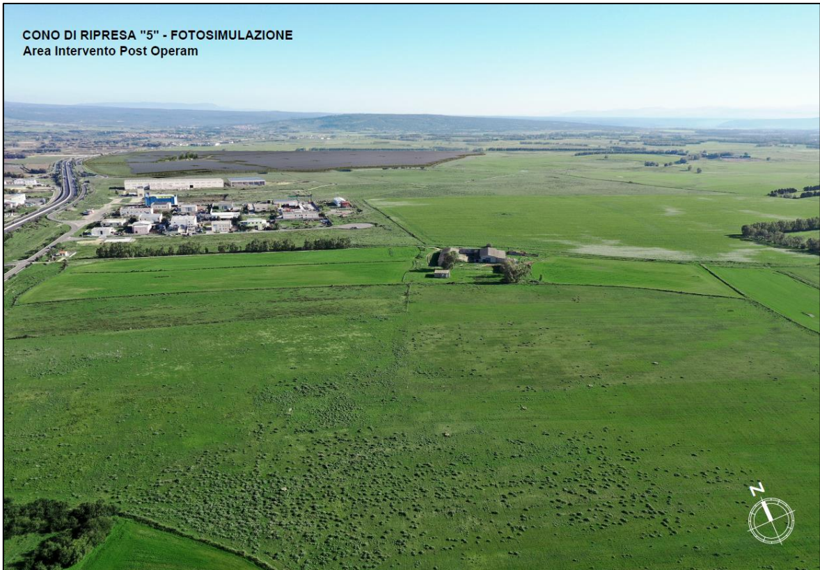
Figura 16: Cono di ripresa 5 – Area Intervento Post Operam
