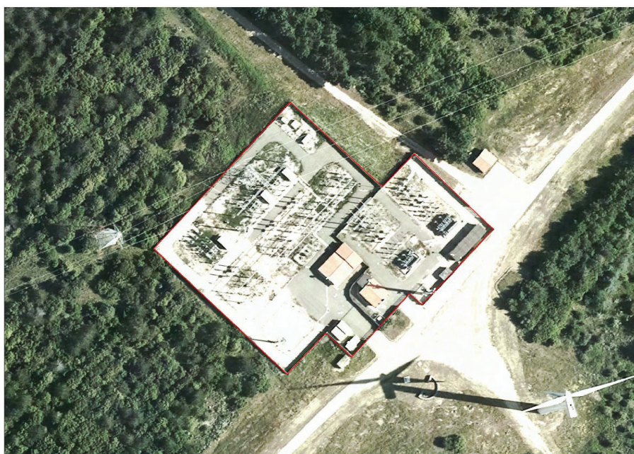
Figura 2 – Stazione Elettrica (SE) esistente denominata “Tula” su Ortofoto
