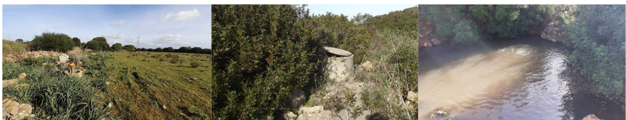
Parallelamente alla strada corre una condotta idrica di cui sono visibili i pozzetti. A sinistra una perdita
