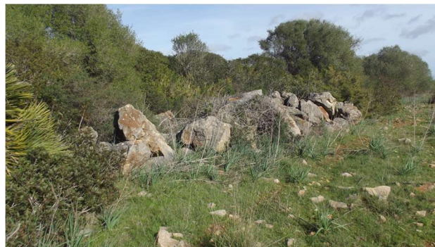
Cumuli di grosse pietre provenienti dagli scavi per la condotta idrica
