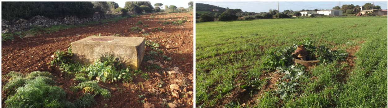
Pozzetti idrici dalle UT 14 e 15
