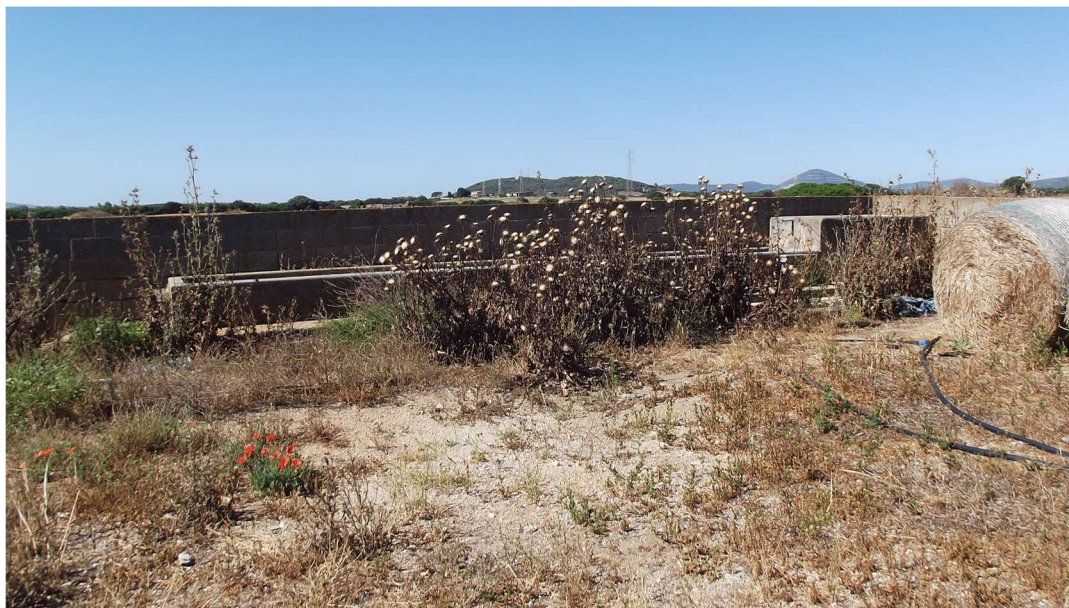
UT 6: abbeveratoio in cemento e struttura in blocchetti
