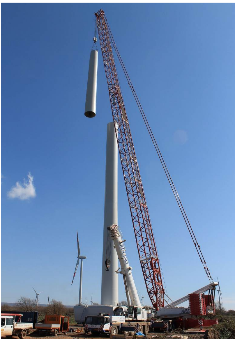
Figura 16: Fase di montaggio della torre
