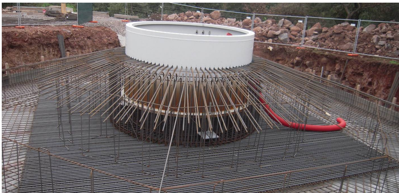
Figura 14: Esempio di fondazione tipo
