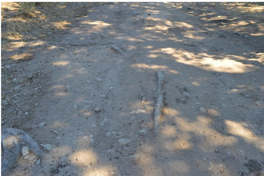
**Figura 84 - Apparati radicali affioranti sul piano carrabile di una pista sterrata nei pressi dell'accesso all'aerogeneratore AG05**
