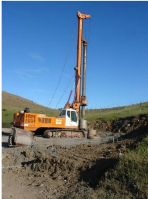
Figura 21 - Esecuzione dei pali di fondazione di un aerogeneratore
