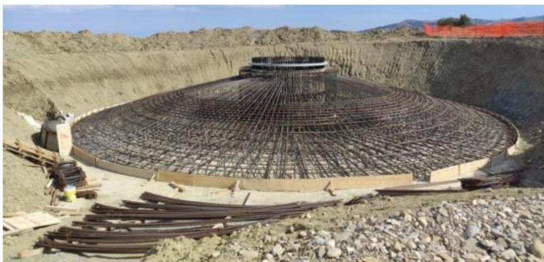
*Figura 9 - Armatura plinto tipo*
