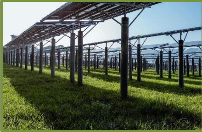
Fig. 90 Esempio di corridoio ecologico con elevata valenza L'area sottostante ai tracker fotovoltaici anche se ritenuta una tara agricola è comunque un'area in cui cresce il prato
