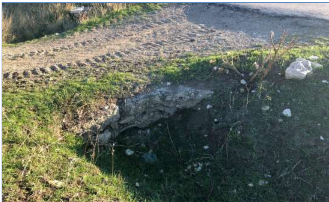
FOTO 5.1 INTERSEZIONE FRA CORSO D'ACQUA MINORE E VIABILITÀ LOCALE
