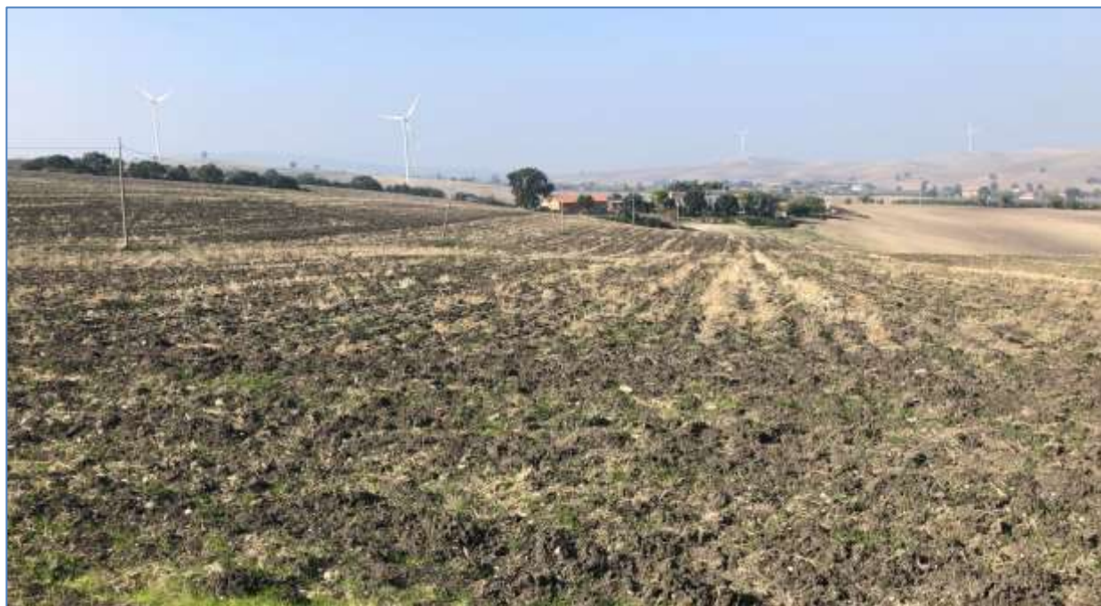
FOTO 5.2 PERDITA DI VERTICALITÀ DEI PALI DELLA LUCE
