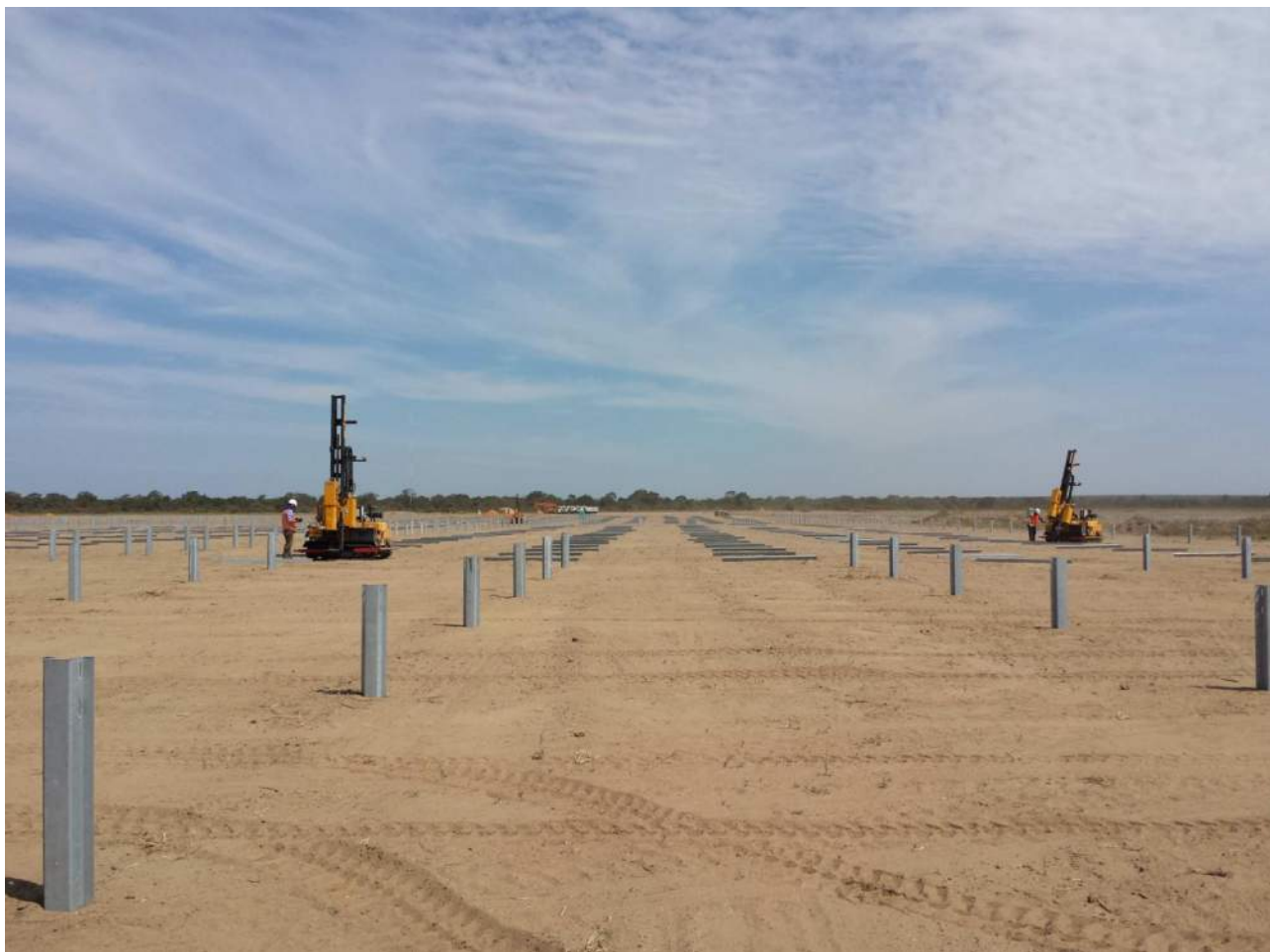
Figura 2.9 – Fase di infissione dei pali con profilo omega (fonte Convert)
