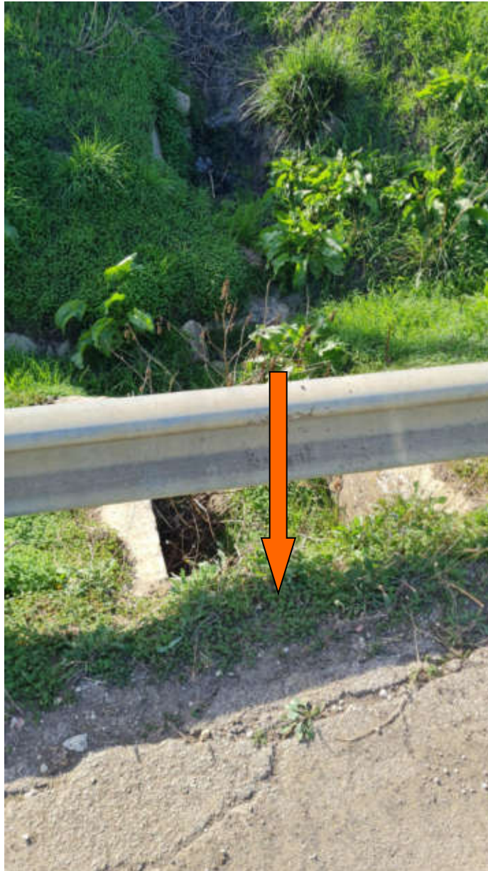
Foto con individuazione canalizzazione sotto viabilità interferenza n.43
