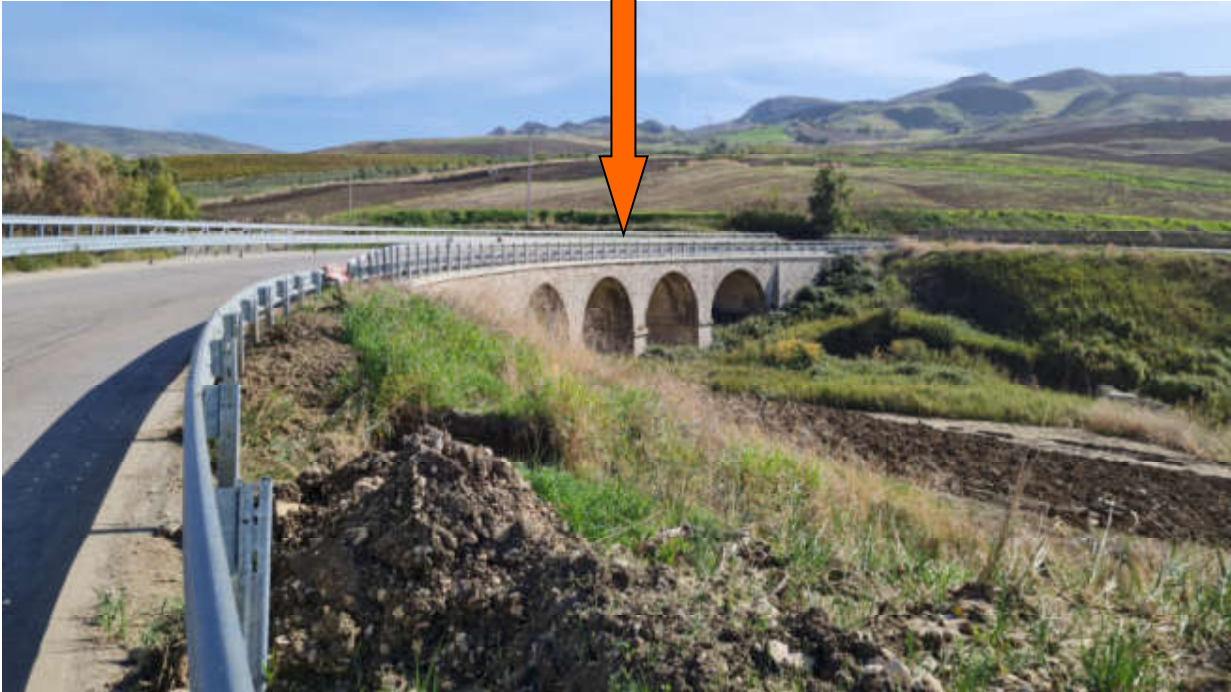
Foto con individuazione canalizzazione sotto viabilità interferenza n.26
