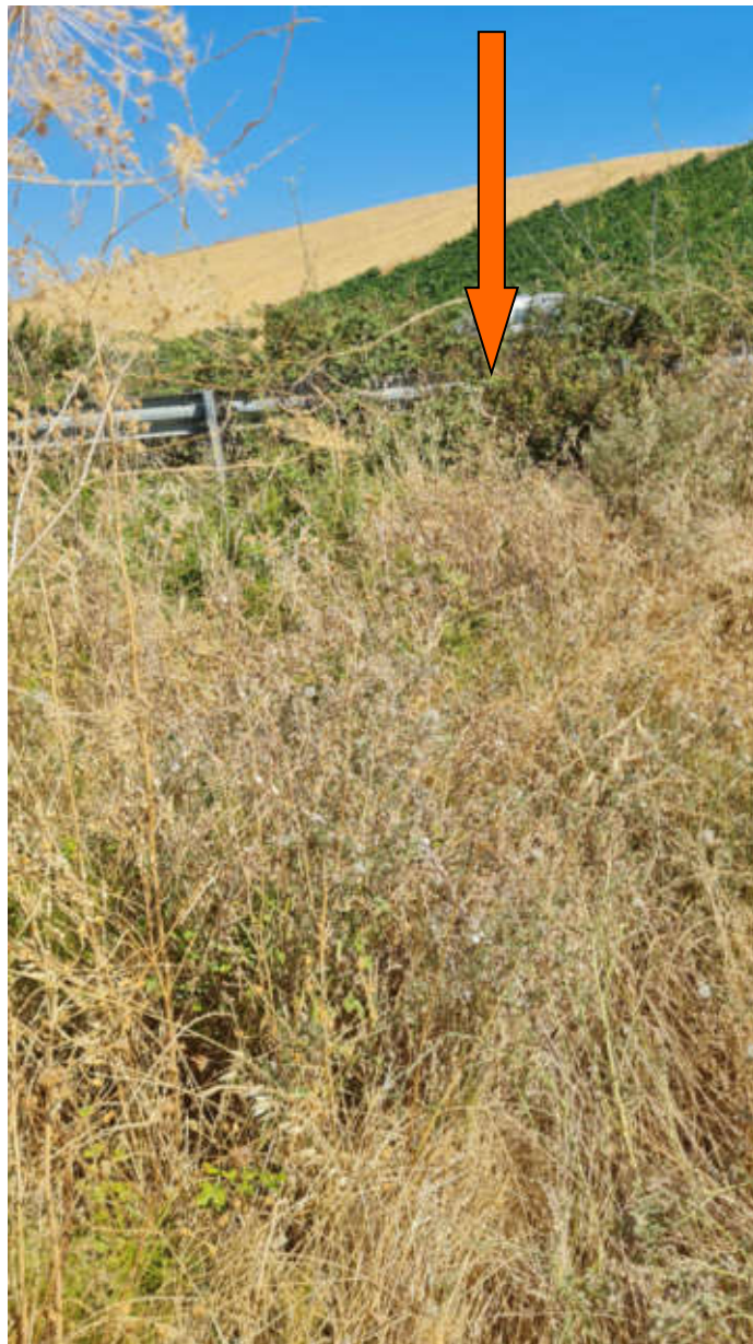
Foto con individuazione canalizzazione sotto viabilità interferenza n.1
