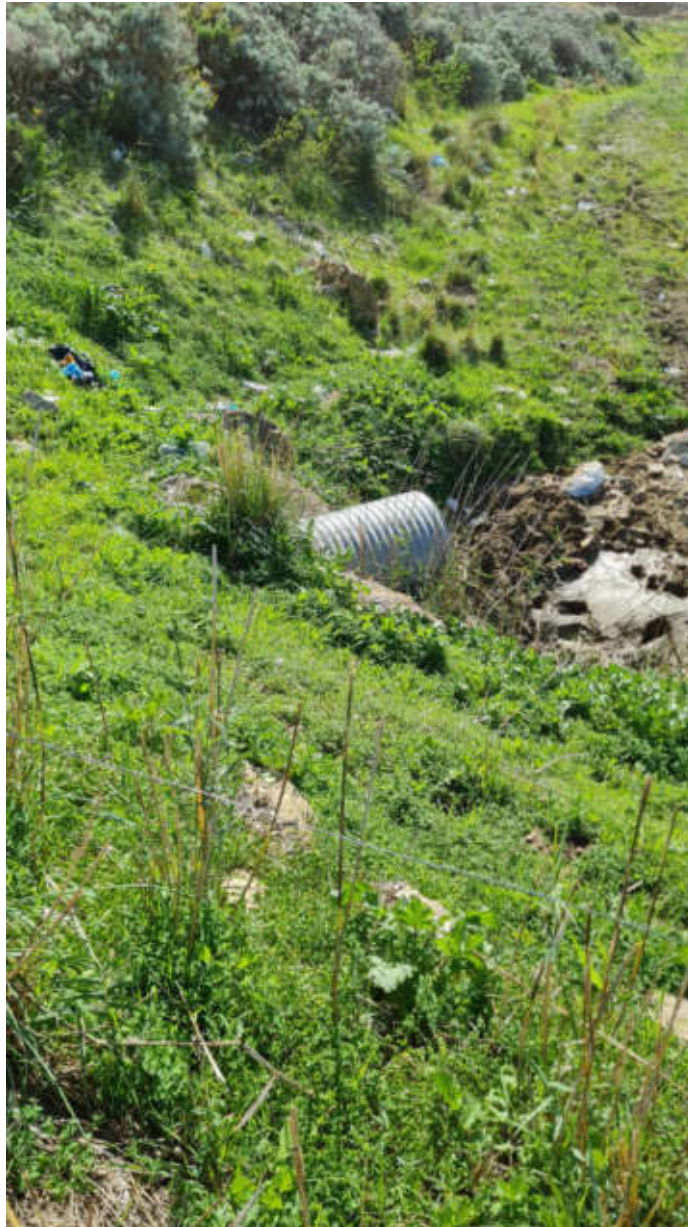
Foto con individuazione canalizzazione sotto viabilità interferenza n.22
