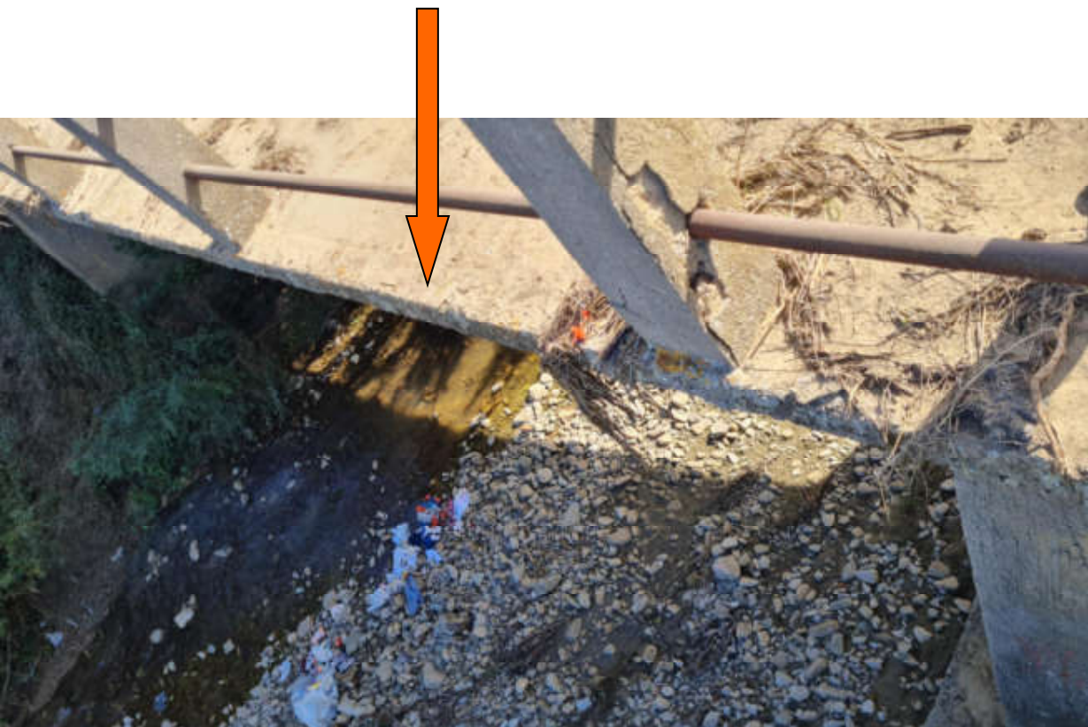
Foto con individuazione canalizzazione sotto viabilità interferenza n.20
