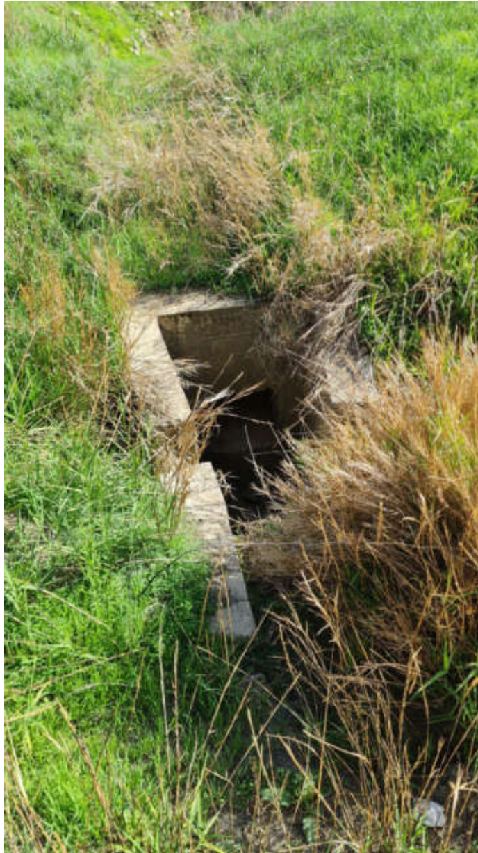
Foto con individuazione canalizzazione sotto viabilità interferenza n.25
