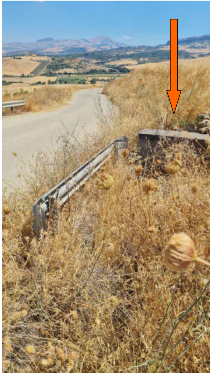
Foto con individuazione canalizzazione sotto viabilità interferenza n.2
