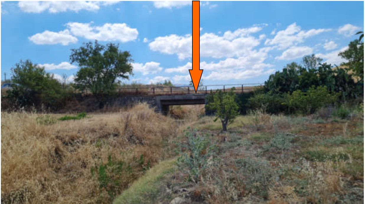
Foto con individuazione canalizzazione sotto viabilità interferenza n.5
