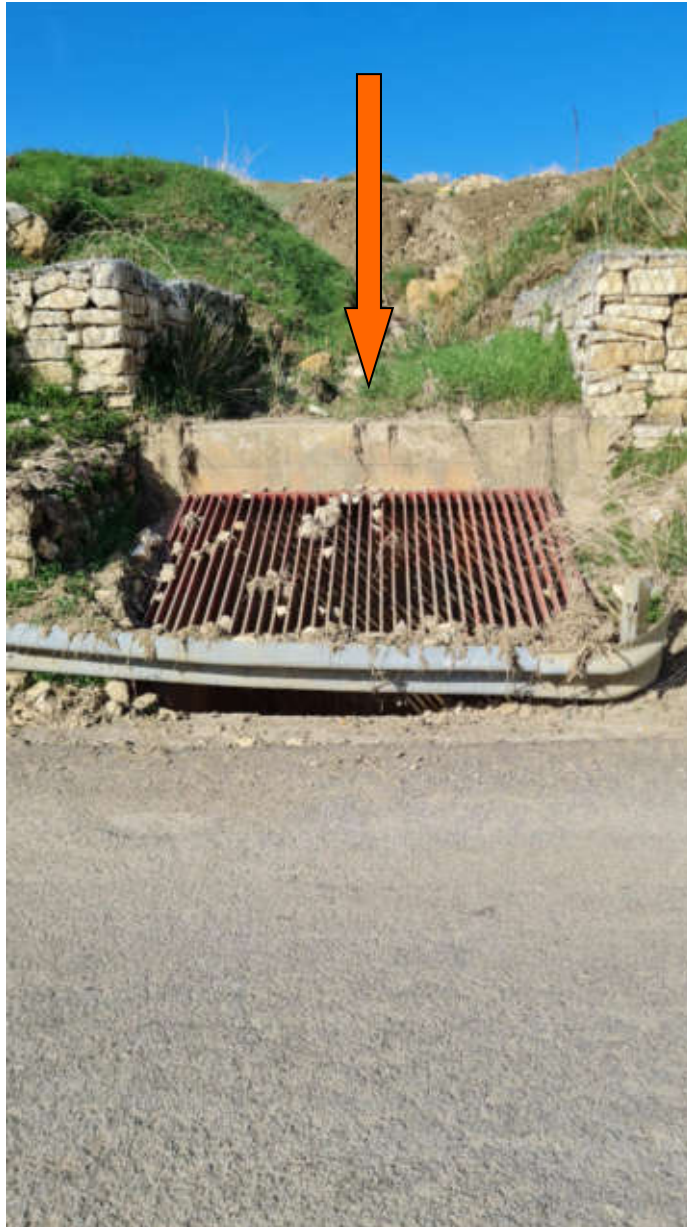
Foto con individuazione canalizzazione sotto viabilità interferenza n.27
