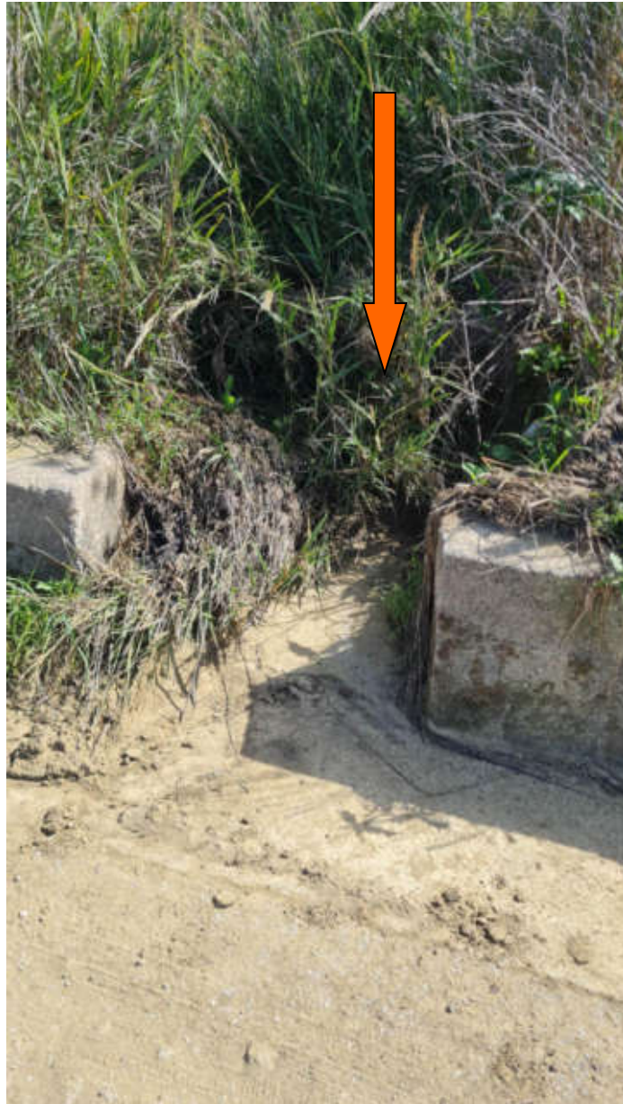
Foto con individuazione canalizzazione sotto viabilità interferenza n.17
