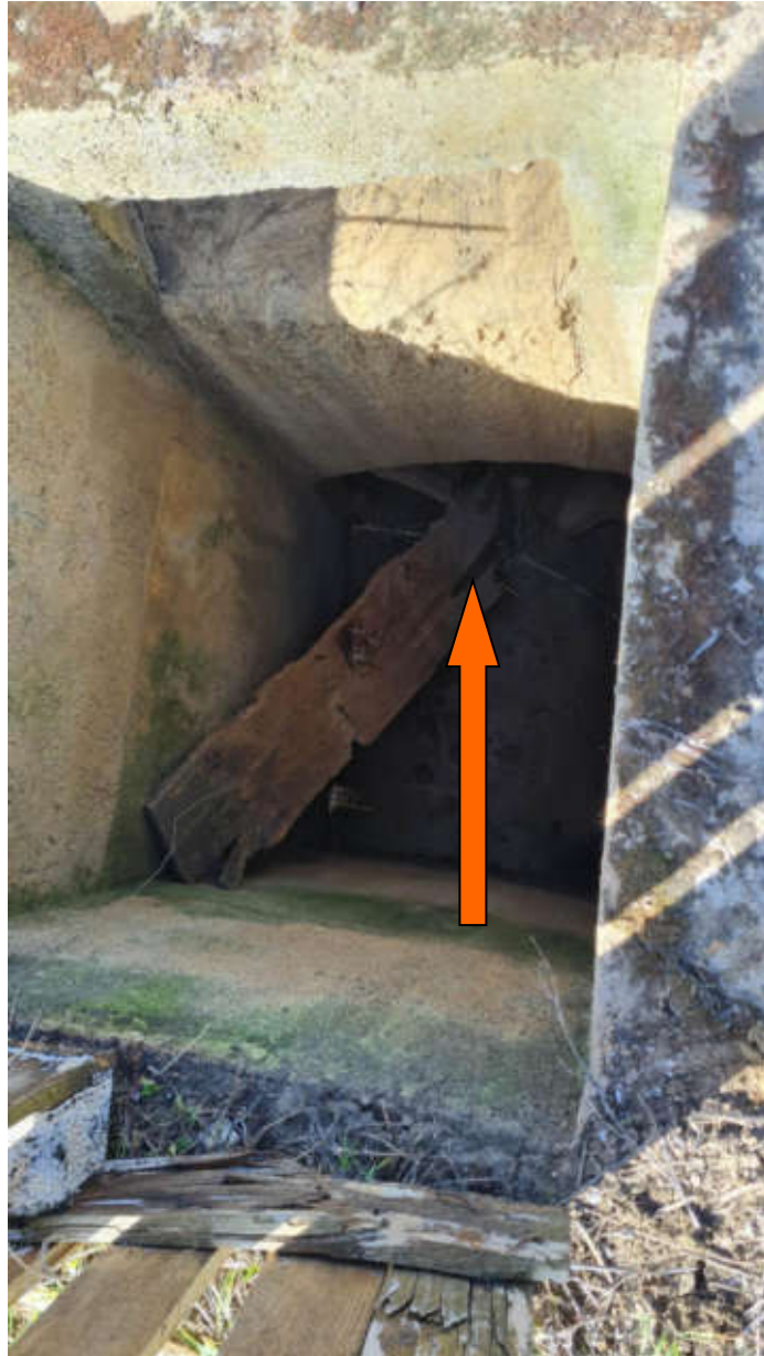
Foto con individuazione canalizzazione sotto viabilità interferenza n.16
