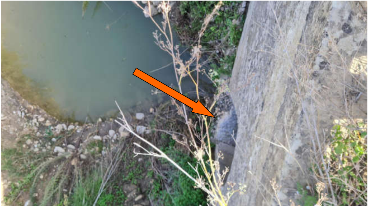
Foto con individuazione canalizzazione sotto viabilità interferenza n.12
