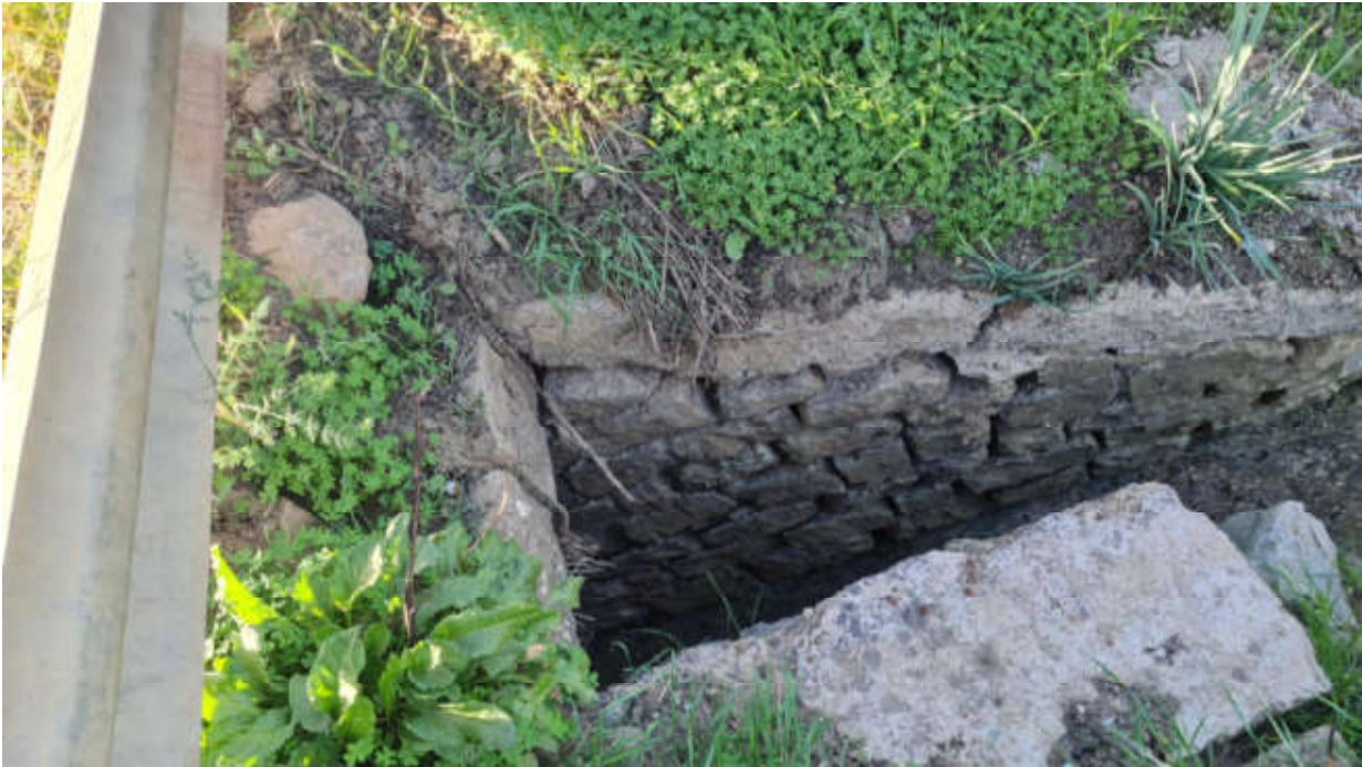
Foto con individuazione canalizzazione sotto viabilità interferenza n.42
