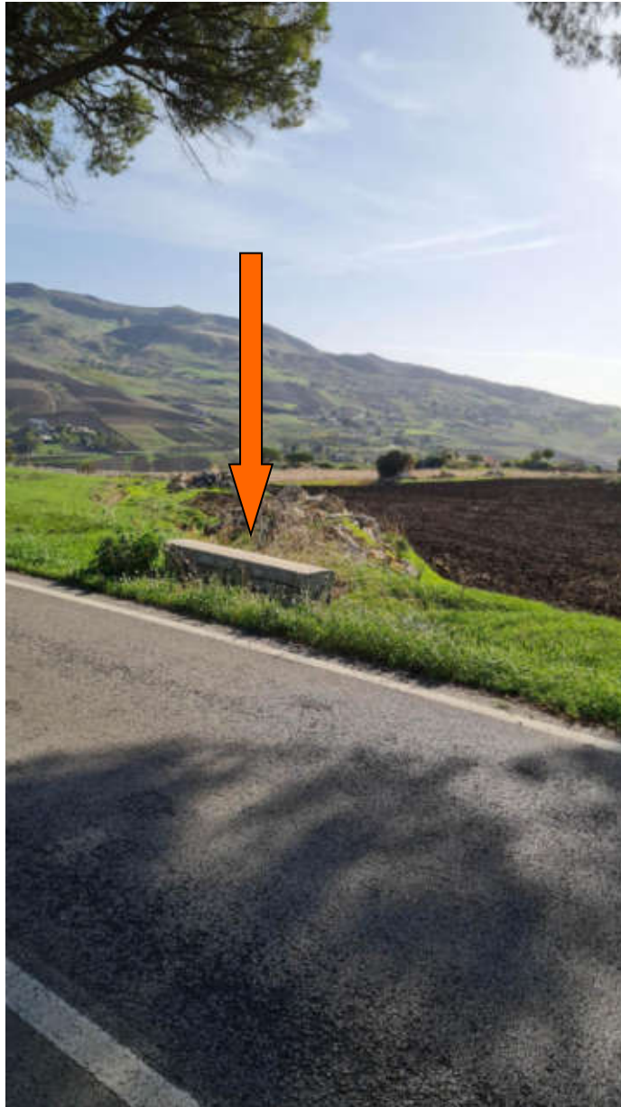
Foto con individuazione canalizzazione sotto viabilità interferenza n.33
