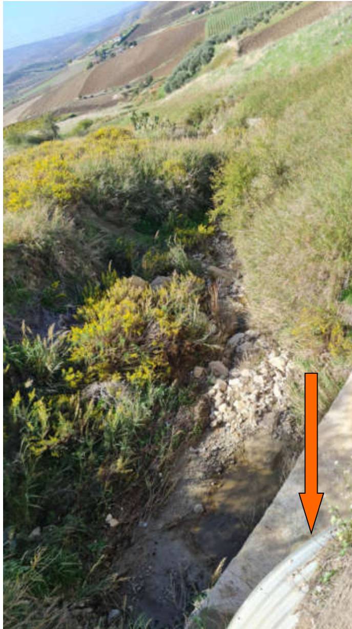
Foto con individuazione canalizzazione sotto viabilità interferenza n.21
