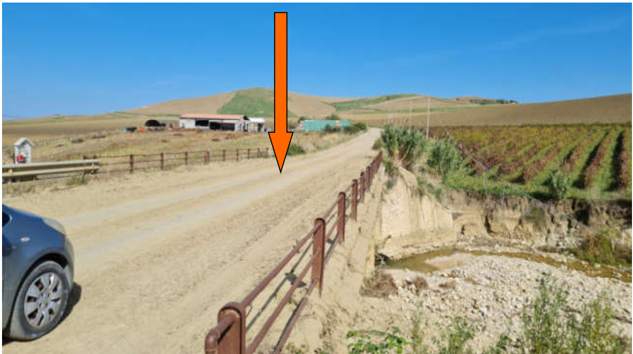
Foto con individuazione canalizzazione sotto viabilità interferenza n.14
