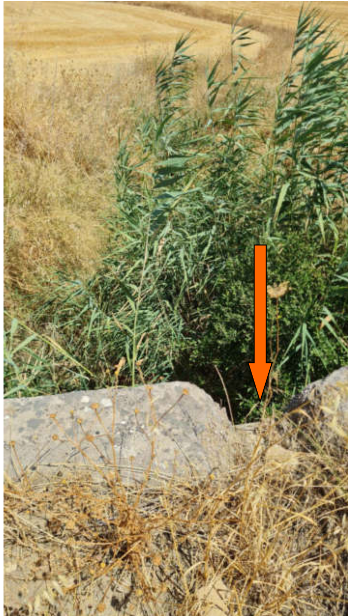
Foto con individuazione canalizzazione sotto viabilità interferenza n.9
