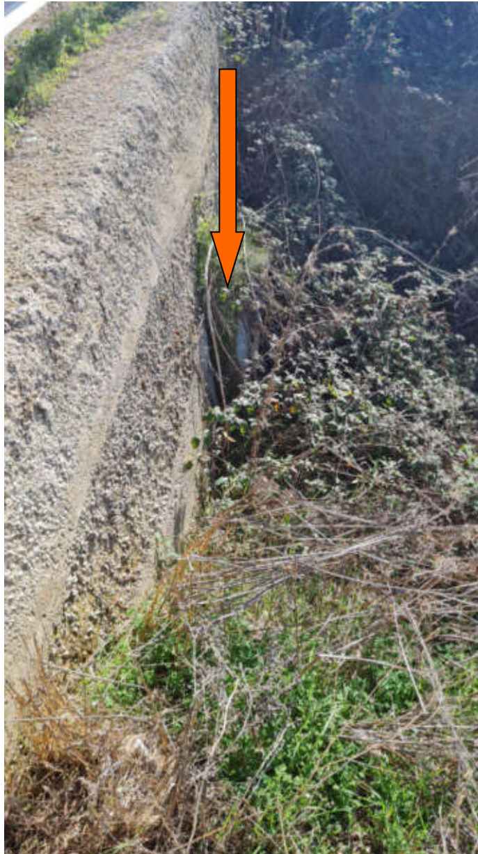
Foto con individuazione canalizzazione sotto viabilità interferenza n.46
