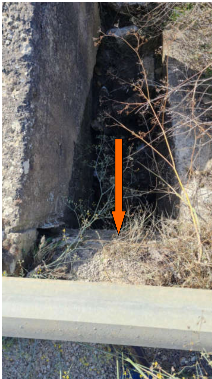
Foto con individuazione canalizzazione sotto viabilità interferenza n.45
