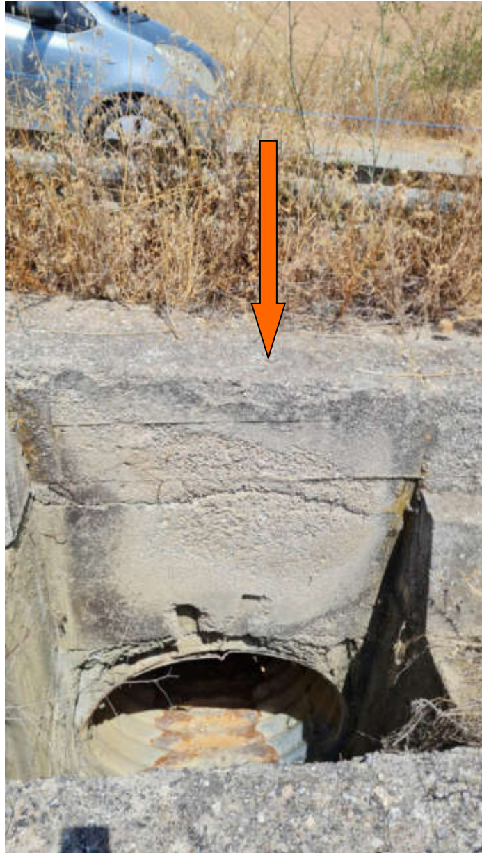
Foto con individuazione canalizzazione sotto viabilità interferenza n.3
