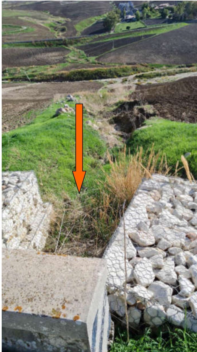
Foto con individuazione canalizzazione sotto viabilità interferenza n.29
