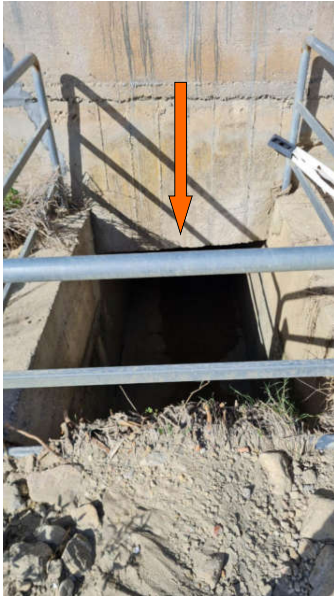
Foto con individuazione canalizzazione sotto viabilità interferenza n.24
