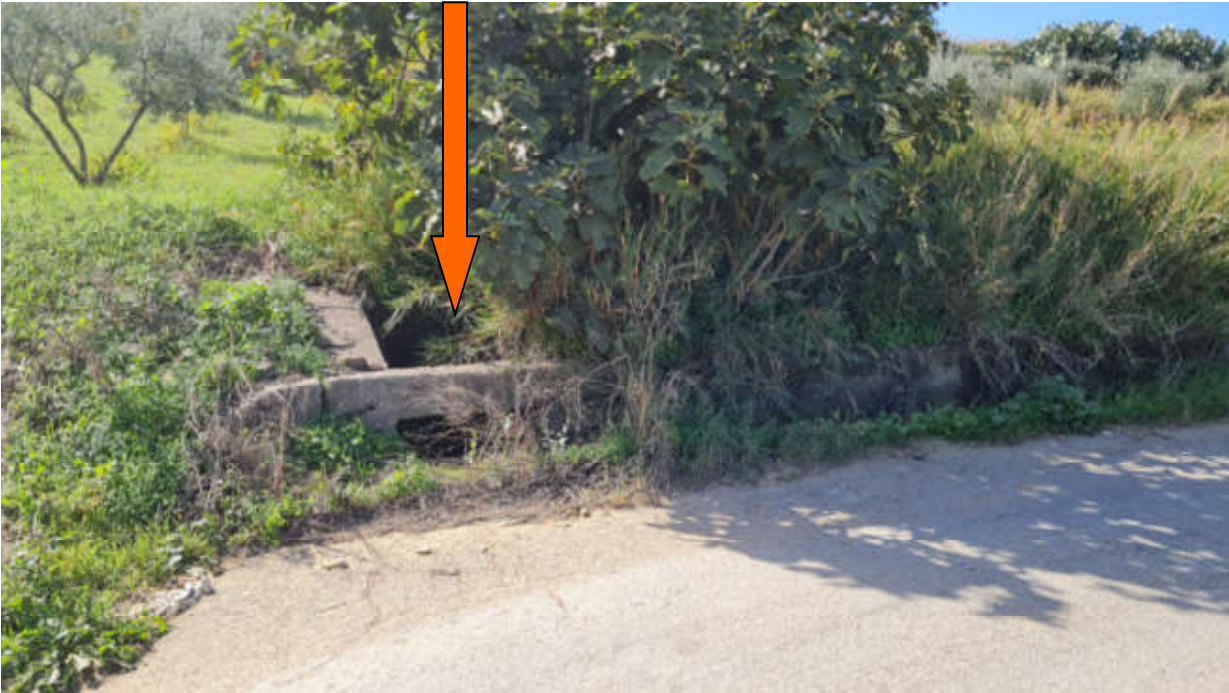
Foto con individuazione canalizzazione sotto viabilità interferenza n.19
