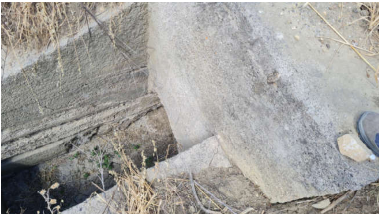
Foto con individuazione canalizzazione sotto viabilità interferenza n.6
