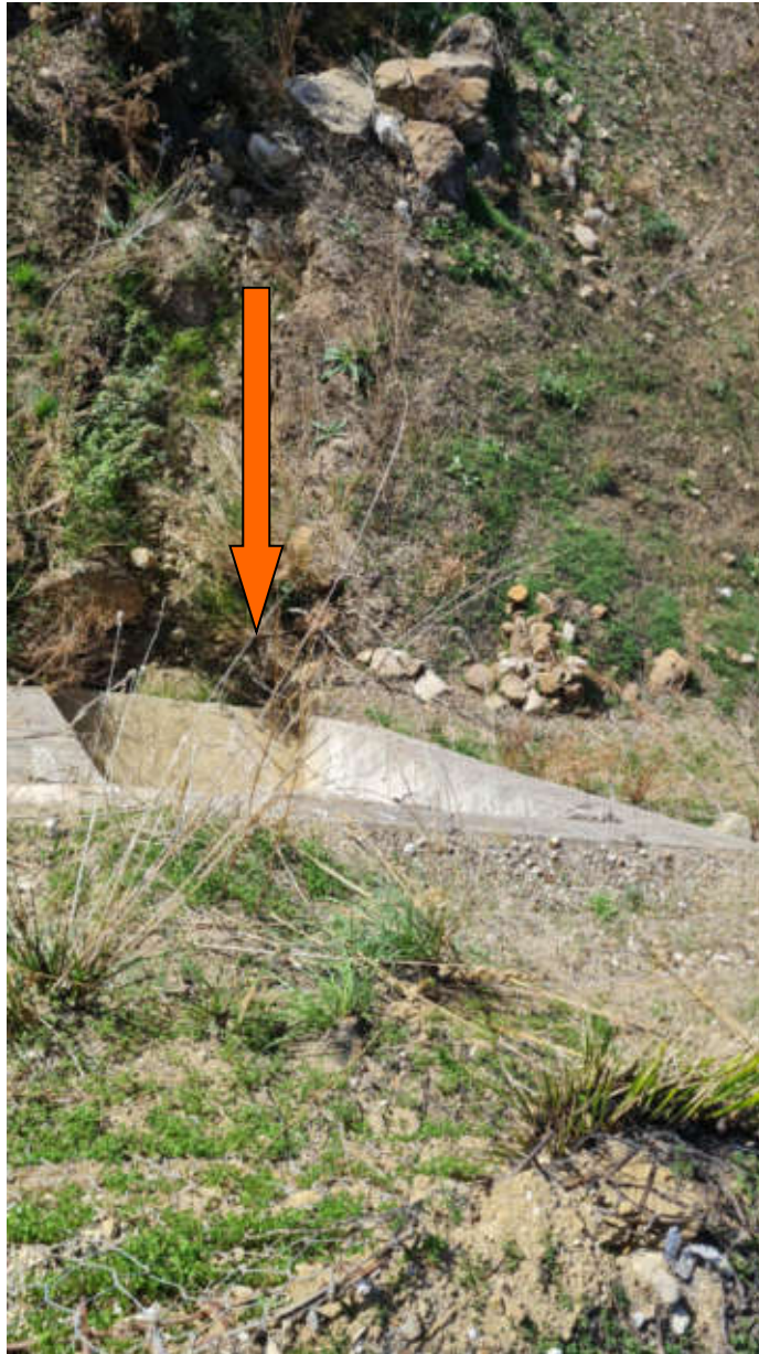
Foto con individuazione canalizzazione sotto viabilità interferenza n.39
