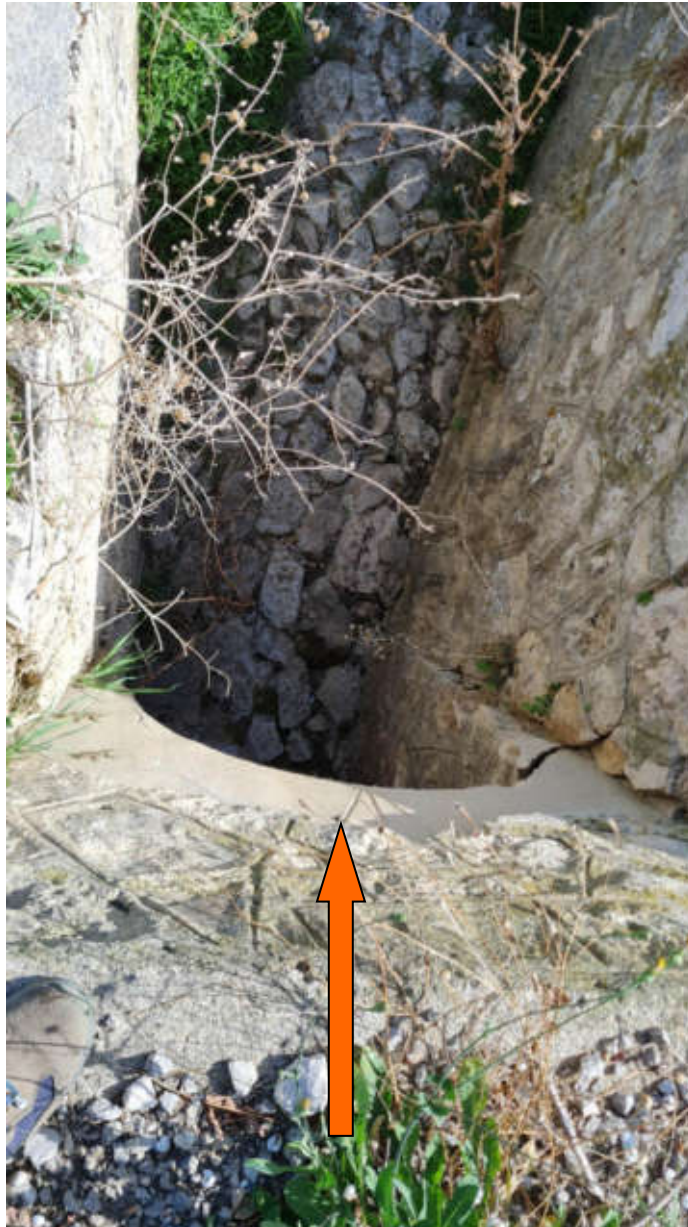
Foto con individuazione canalizzazione sotto viabilità interferenza n.32
