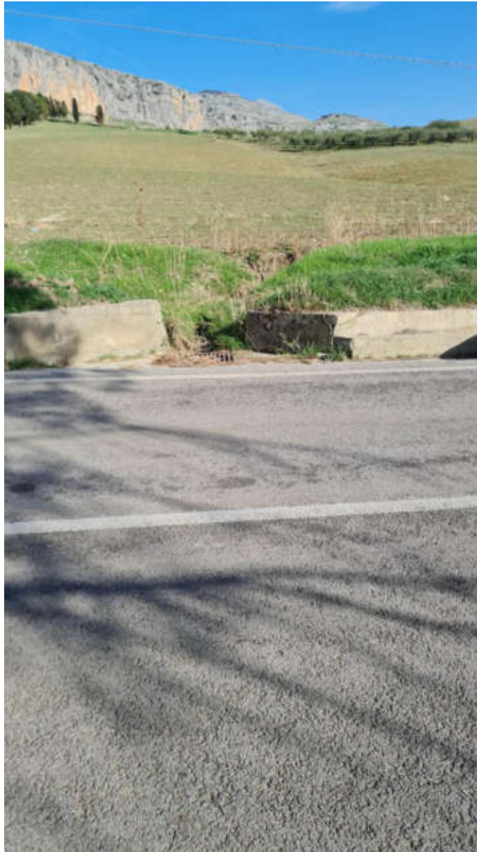
Foto con individuazione canalizzazione sotto viabilità interferenza n.34
