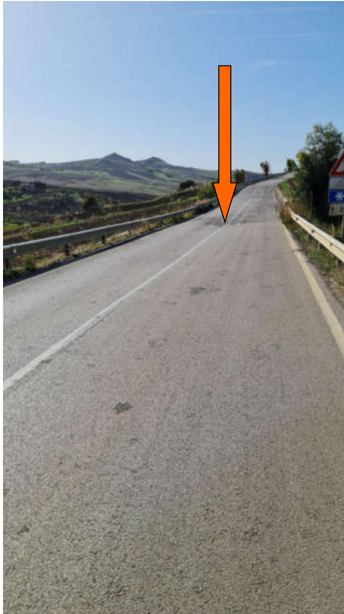
Foto con individuazione canalizzazione sotto viabilità interferenza n.28
