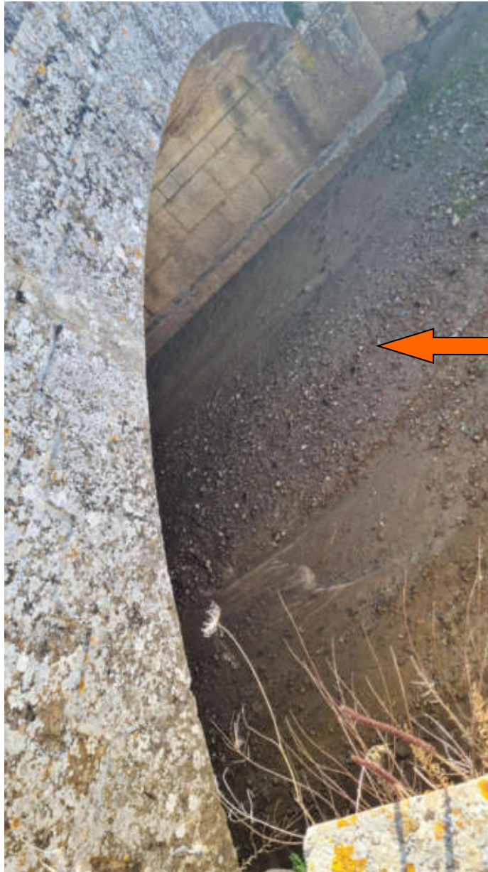
Foto con individuazione canalizzazione sotto viabilità interferenza n.40
