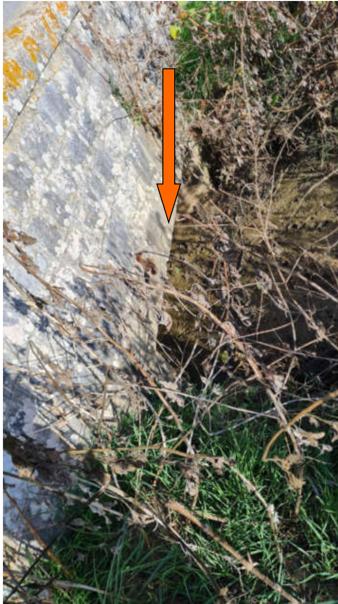
Foto con individuazione canalizzazione sotto viabilità interferenza n.47
