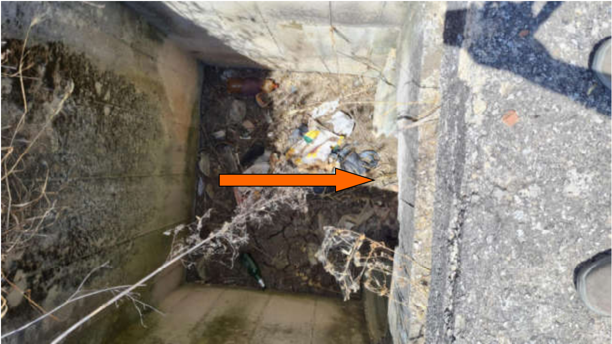
Foto con individuazione canalizzazione sotto viabilità interferenza n.7
