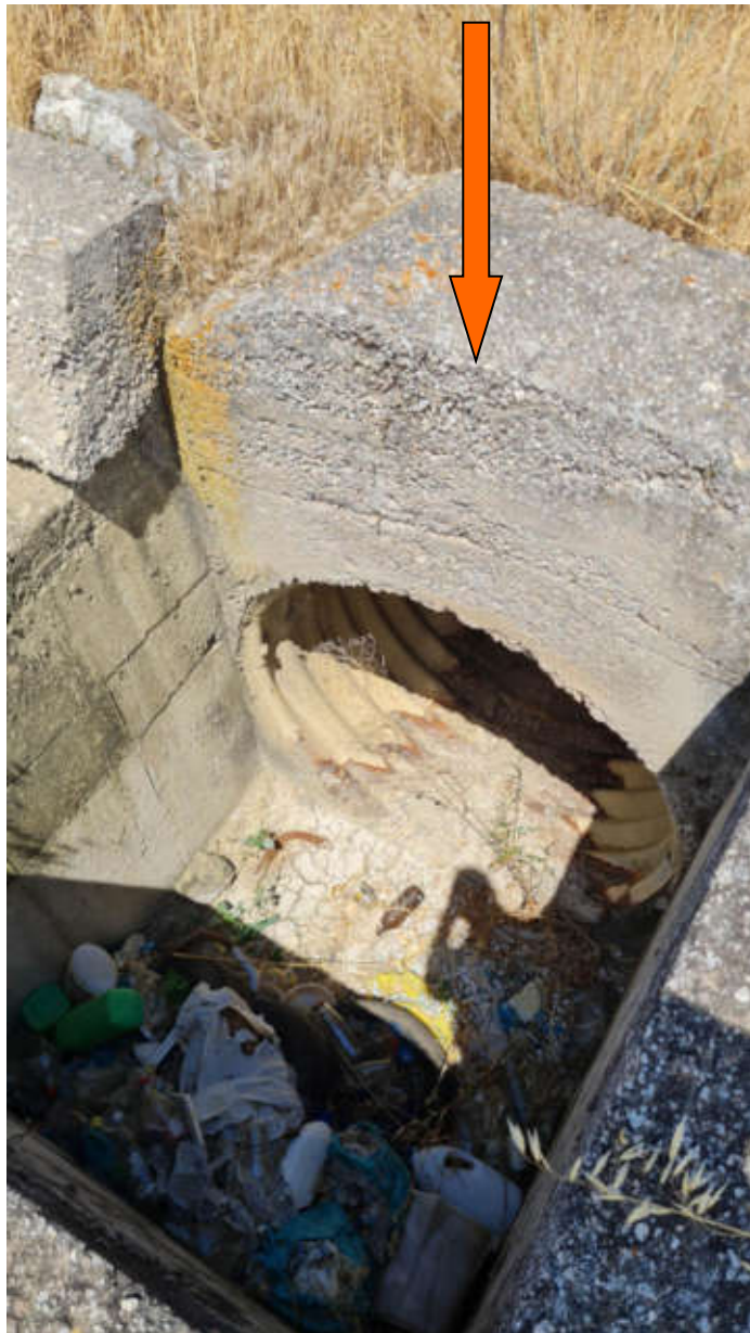
Foto con individuazione canalizzazione sotto viabilità interferenza n.4
