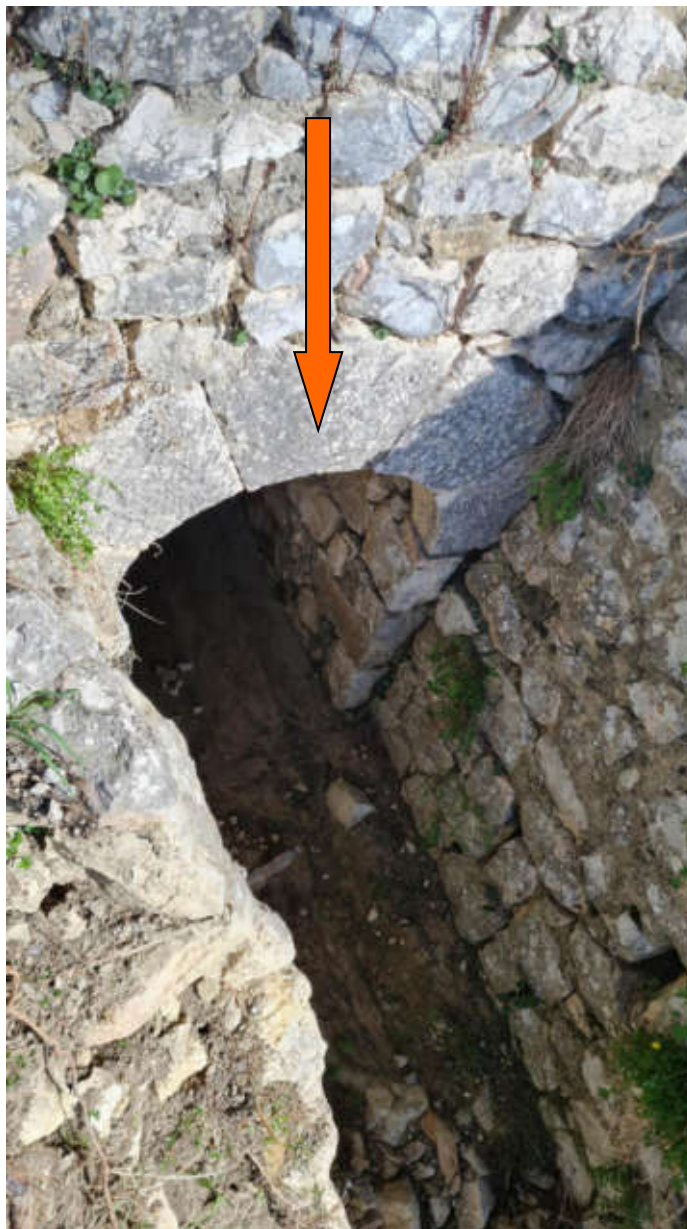
Foto con individuazione canalizzazione sotto viabilità interferenza n.35
