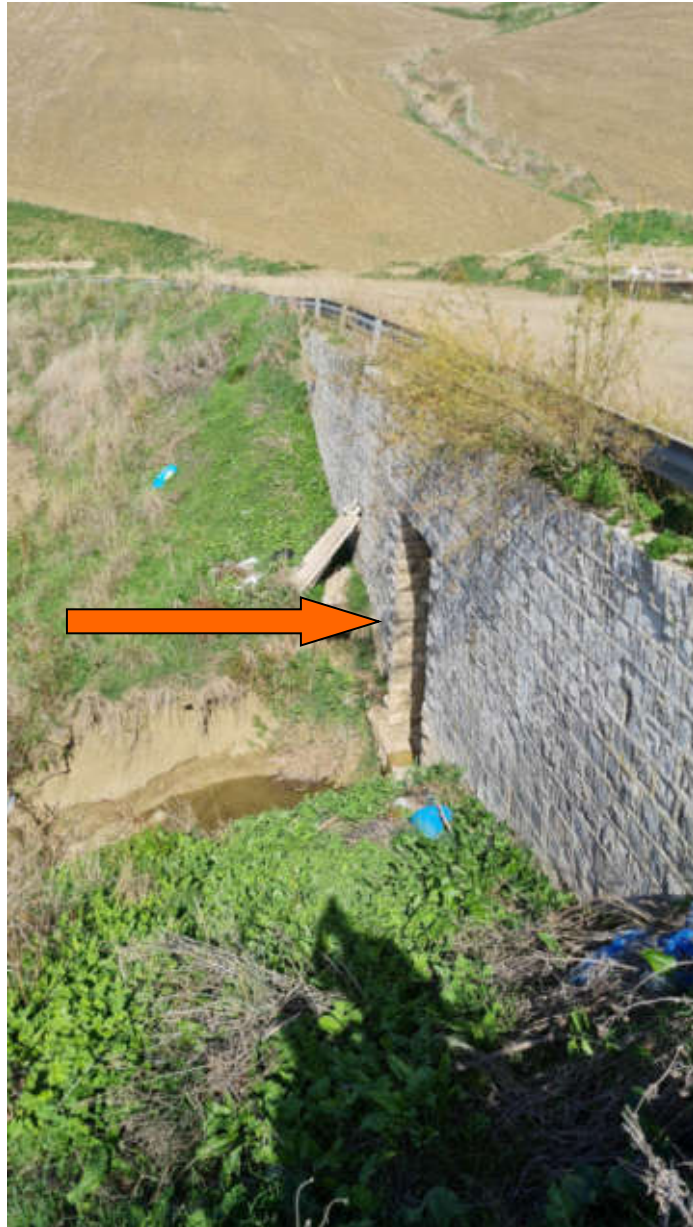
Foto con individuazione canalizzazione sotto viabilità interferenza n.15
