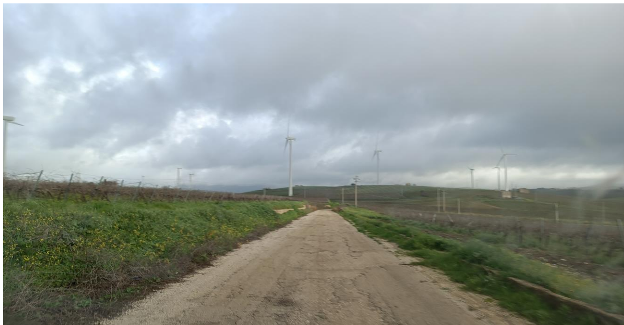
Figura 23 – Viabilità di collegamento con la WTG 6
