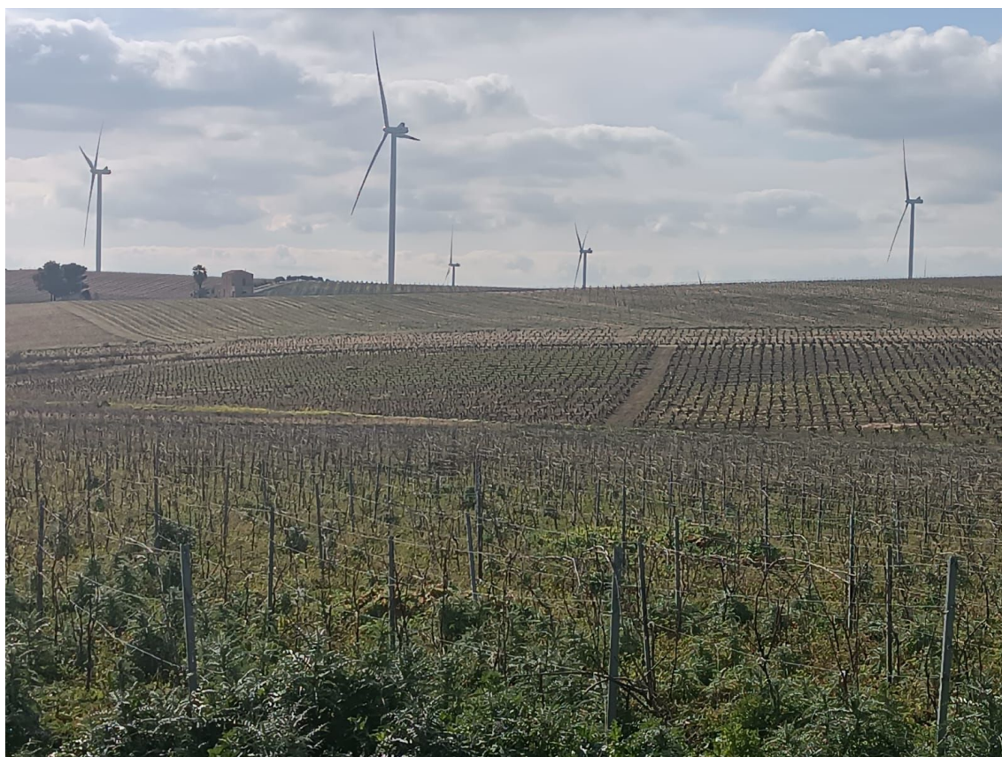
Figura 10 - Area torre ID WTG 6
