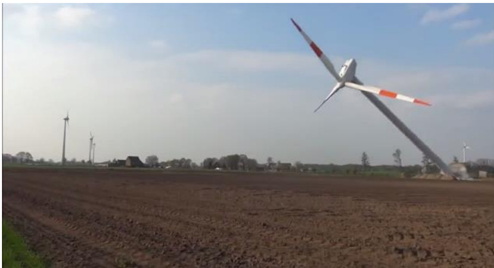
Figura 9- Ribaltamento della torre alla radice
