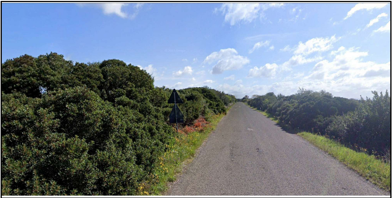
Figura 26 – Foto 9 (Strada SP65)
