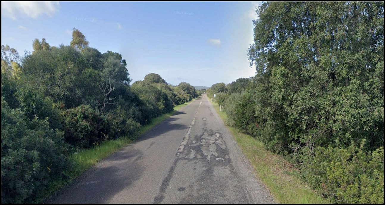
Figura 27 – Foto 10 (Strada SP65)
