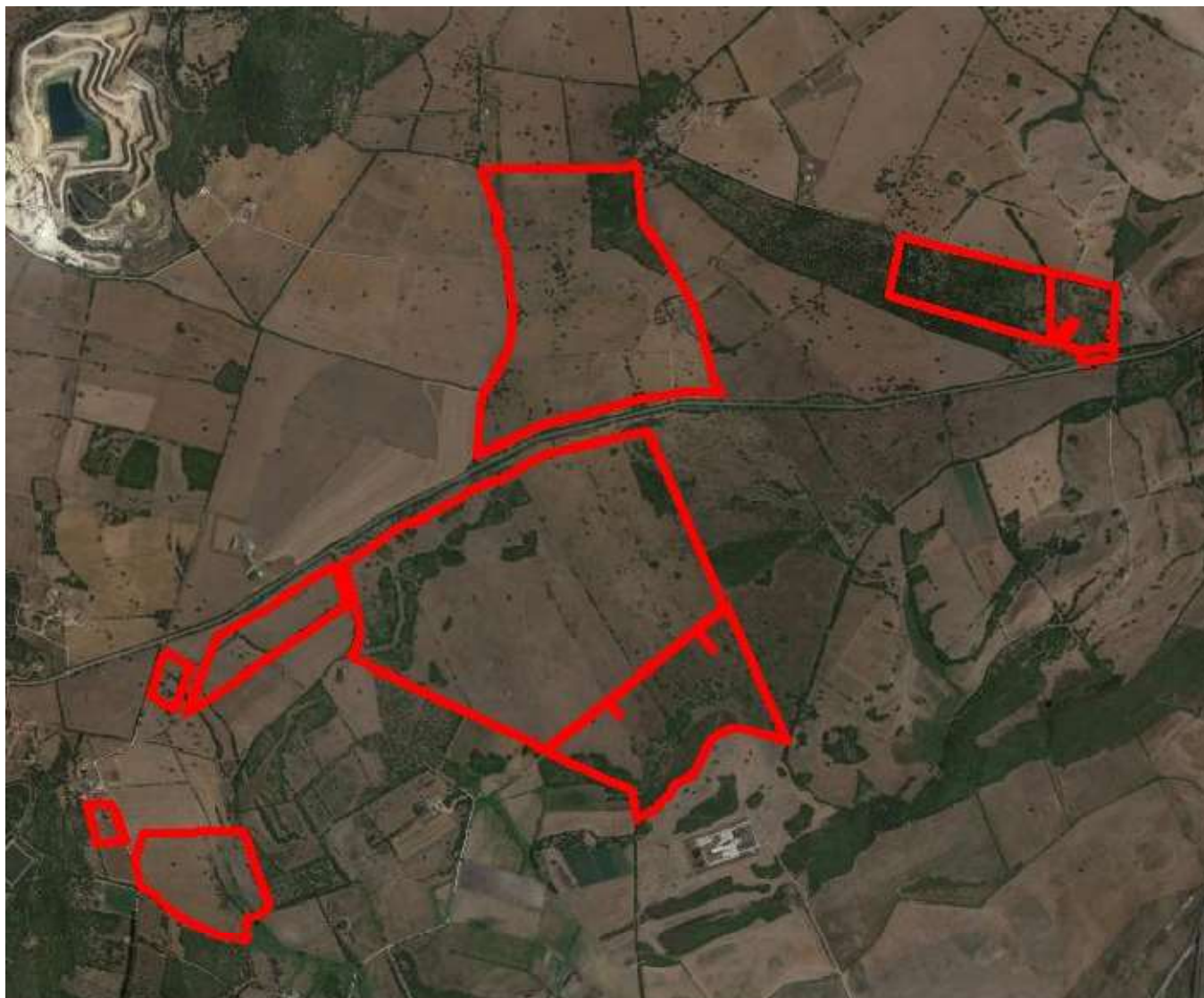
Figura 5 - Inquadramento dell'impianto su ortofoto
