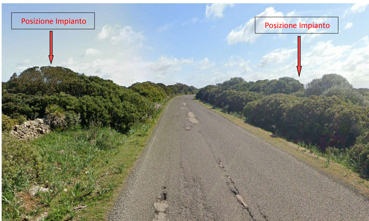
PUNTO DI SCATTO N.2 POST – Strada Provinciale n.65
