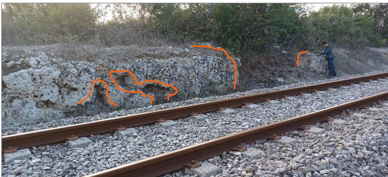
Figura 12-8 – Settore ST27 – Calcareniti affioranti lungo la trincea ferroviaria con cavità carsiche (evidenziate in arancione)
