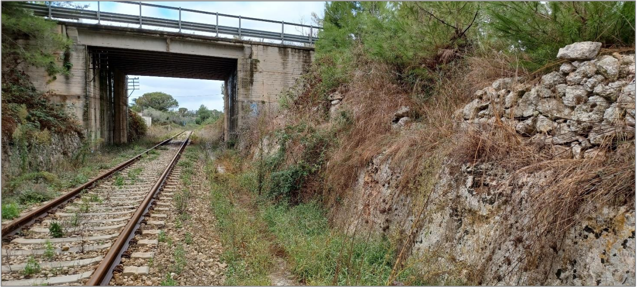
Figura 12-18 – Settore ST1 – Vista da NE con trincea ferroviaria in calcareniti
