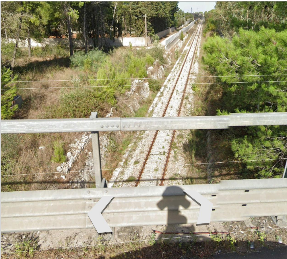
Figura 12-17 – Settore ST1 – Vista da SW con trincea ferroviaria in calcareniti
