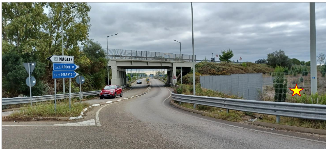
Figura 12-20 – Settore ST22 – Vista da ovest
