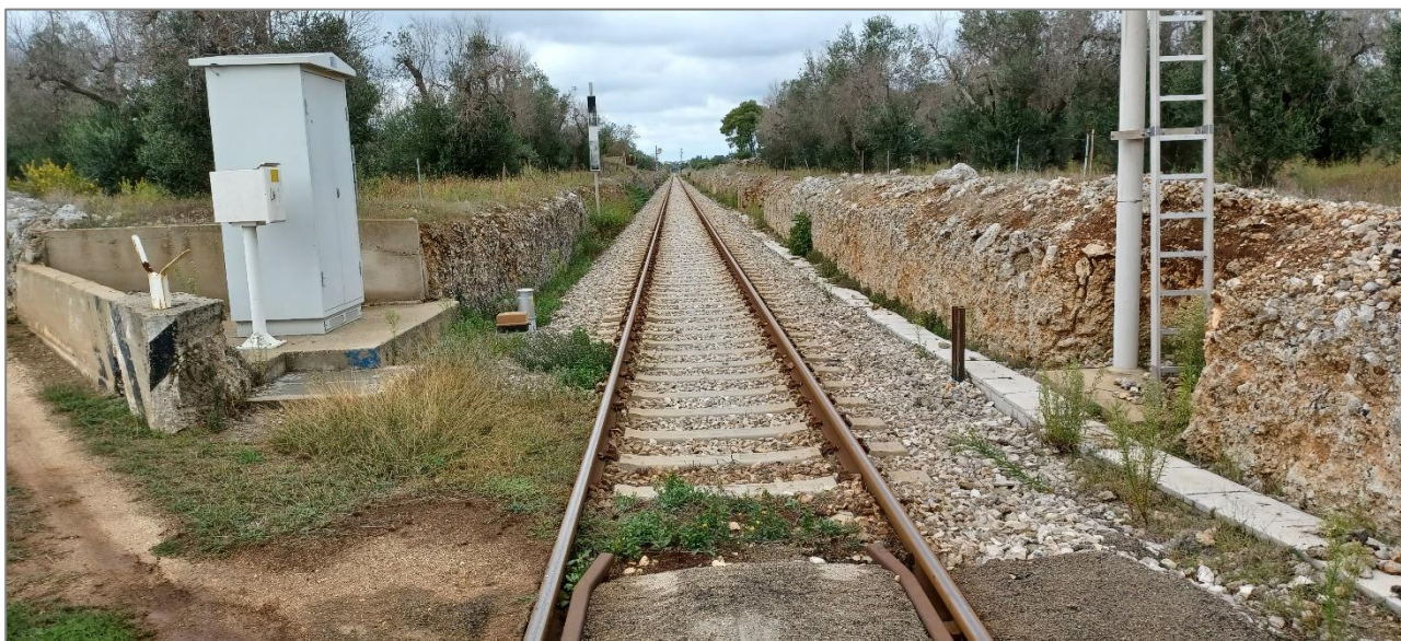
Figura 12-26 – Settore OM3 – Vista da SE con trincea ferroviaria in calcareniti
