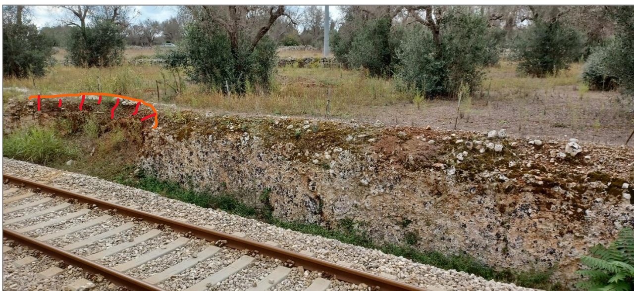
Figura 12-27 – Settore OM3 – Vista da NE con trincea ferroviaria in calcareniti localmente soggette a erosione/dissoluzione carsica (orlo di erosione/dissoluzione in colore arancione)
