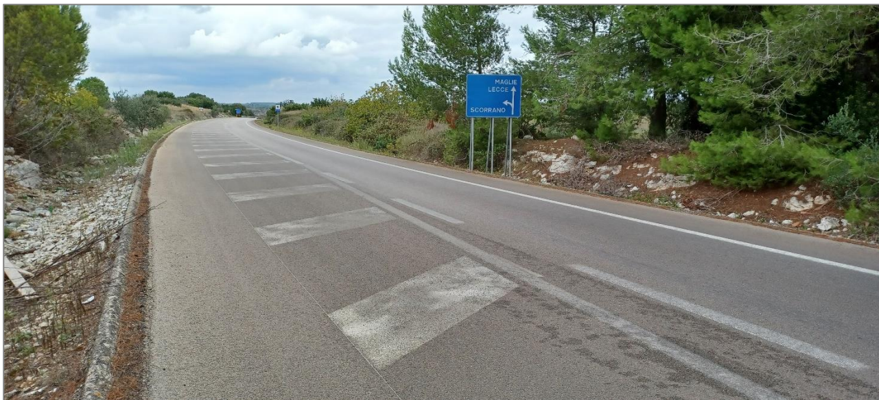
Figura 12-34 – Settore CV5 – Vista da sud con calcareniti affioranti
