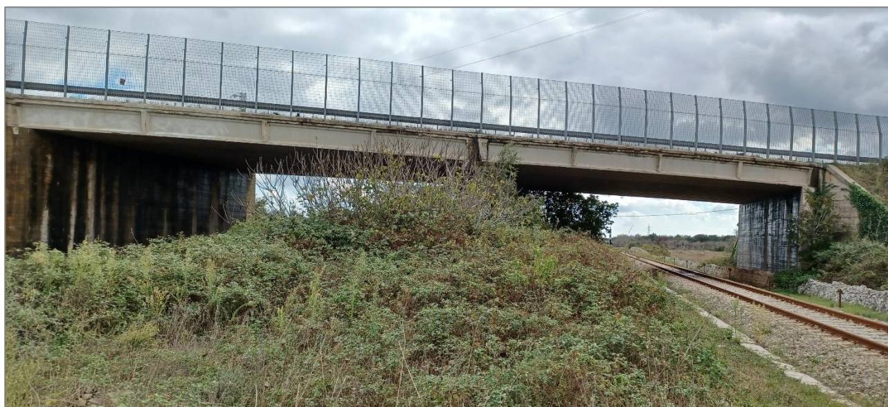
Figura 12-29 – Settore ST23 – Vista da WNW
