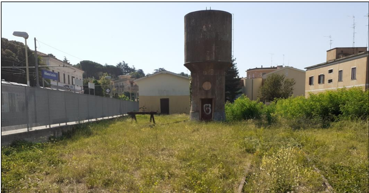
Figura 13 – Torre piezometrica oggetto di demolizione
