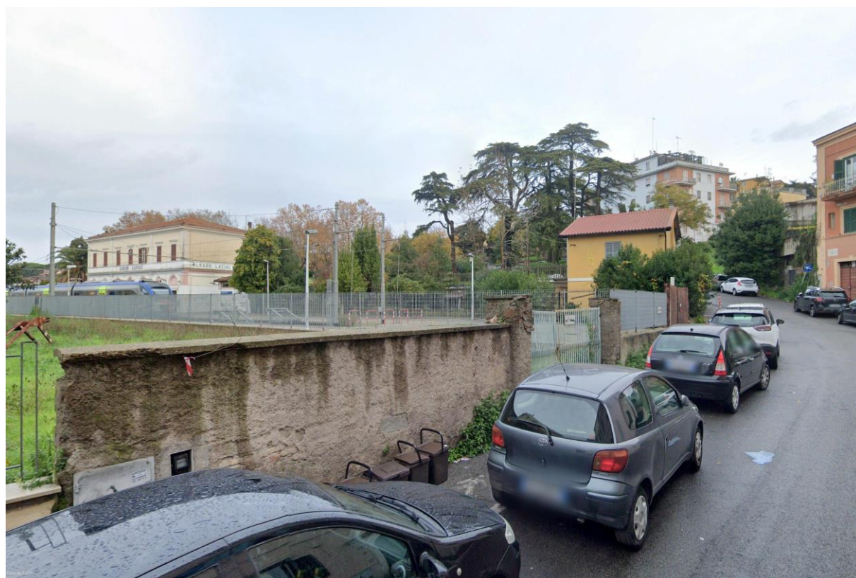
Figura 4-1 Visuale della strada di accesso alla SSE da Via Giuseppe Verdi
