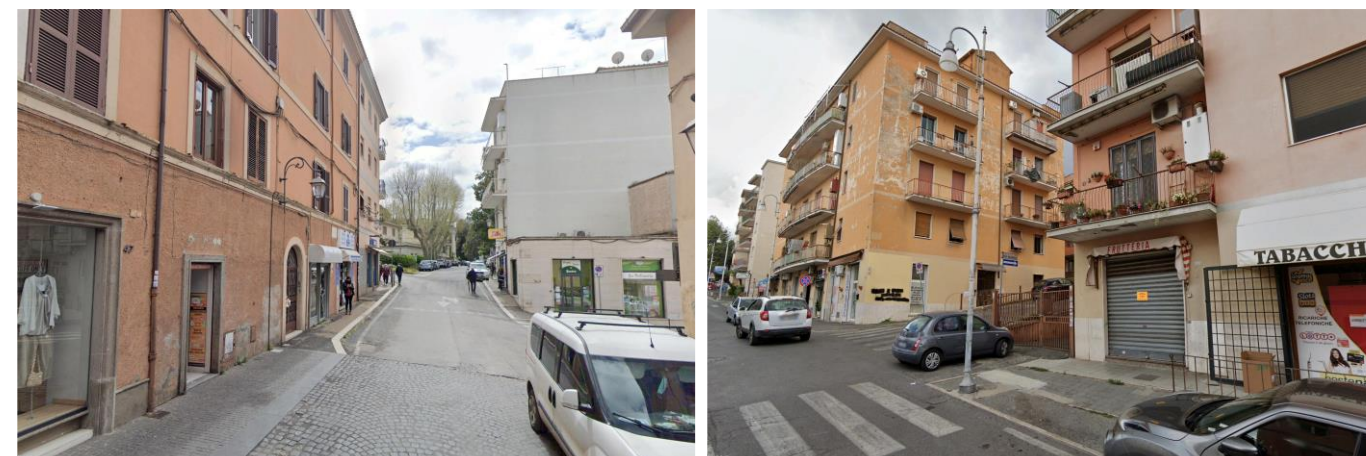
Figura 2-20 Esempi di tessuto compatto mediamente denso dove il piano terra è occupato da esercizi commerciali
